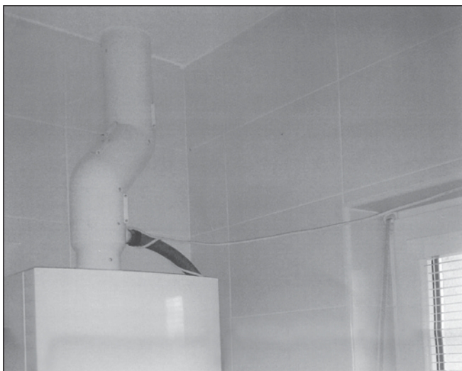
Obr. 2 Příklad instalace plynového kotle v koupelně
