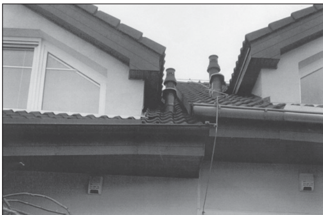
Obr. 3 Příklad vyústění potrubí odvodu spalin
