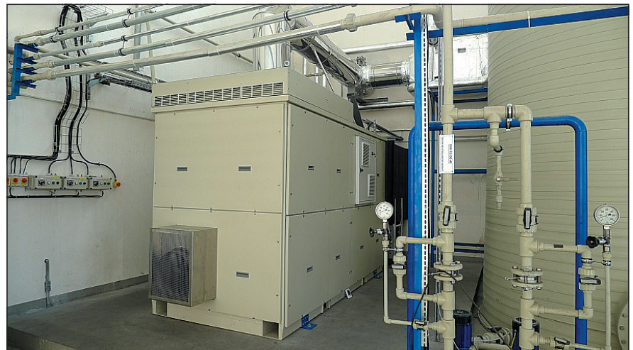
▼ Obr. 4 ● Mikroturbína v reálné instalaci (ilustrativní obrázek z jiné akce)
