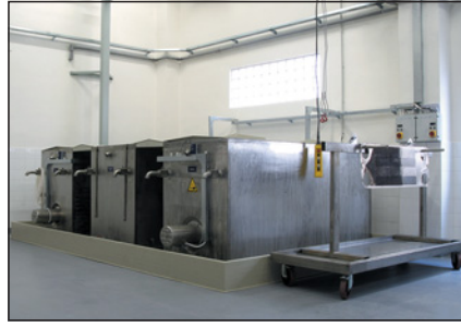
▲ Obr. 8 ● Dokonalé očištění desek je prováděno za použití tlakové vody a chemické lázně, jejíž koncentrace a teplota je pečlivě regulována
