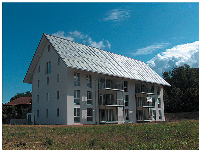
◀ Obr. 1 ● Pohled na objekt od jihozápadu
