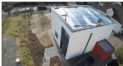
▲ Obr. ● Fotovoltaika má výkon 6,6 kWp a počítá se s roční výrobou 6270 kWh (950 kWh/kWp)
