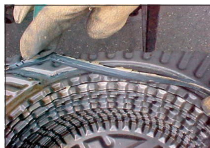
▲ Obr. 3 ● Pokud není původní těsnění a lepidlo úplně odstraněno, hrozí netěsnost
