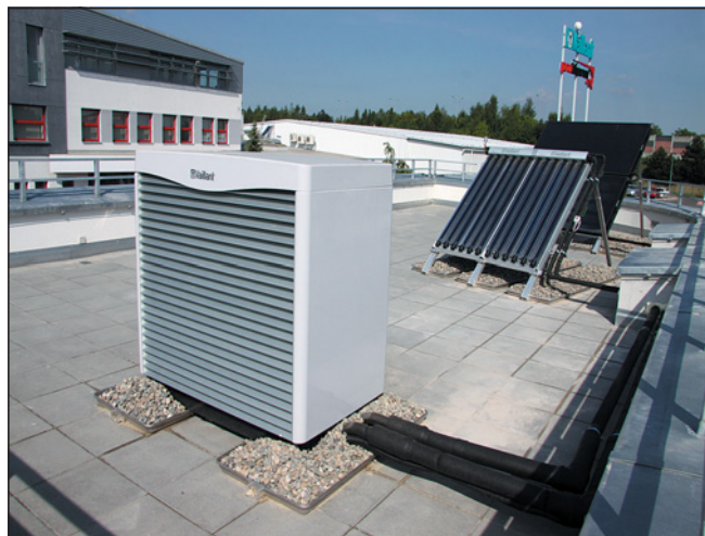
Obr. 2 Prostor ploché střeše s instalovanými solárními panely a venkovní jednotkou je účastníkům školení bezpečně přístupný po schodech
