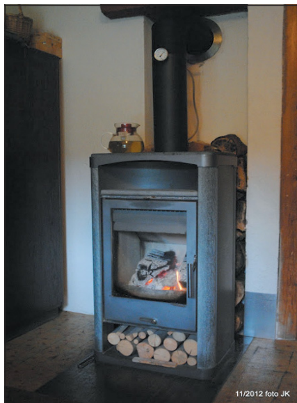
Obr. 1 Příklad umístění teploměru za krbovými kamny
