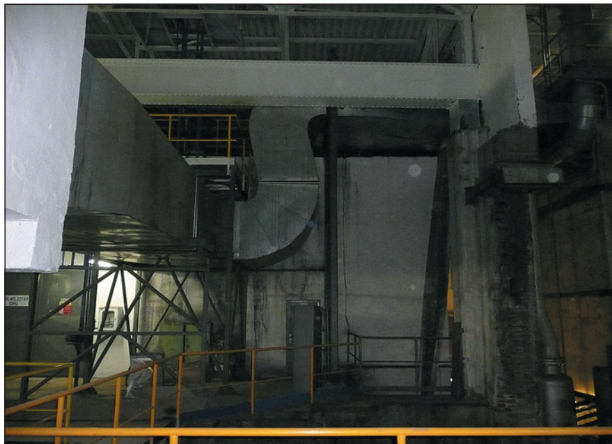
Obr. 1 Praktické provedení kouřovodu
