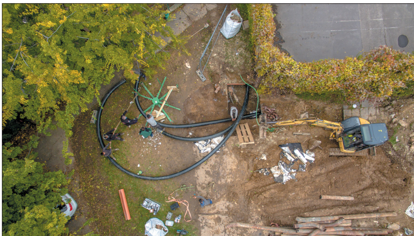
▼ Obr. 1 ● Nasouvání flexibilního plastového potrubí do existujícího kanálu
