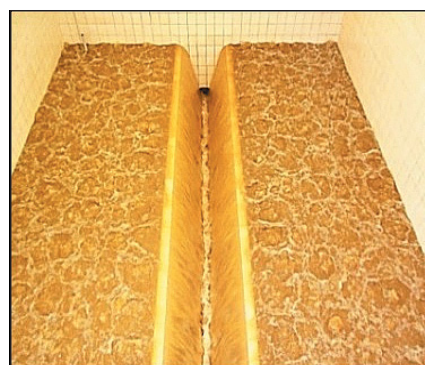
▲ Obr. 11 ● Praní (regenerace) filtrů
