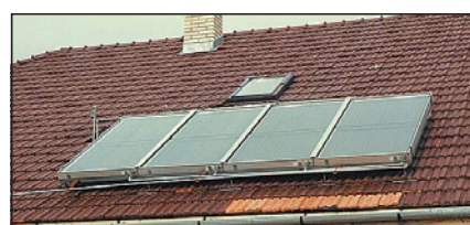
▲ Obr. 3 ● Tichelmannova smyčka je sice na dolním přívodu do kolektorů, ale nad střešním pláštěm (ještě před izolací)
