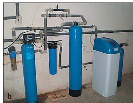
▲ Obr. 3 ● Domovní úprava pro a) jeden zařizovací předmět b) celou bytovou jednotku
