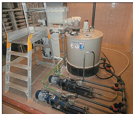
▲ Obr. 8 ● Zásobník vápenného mléka
