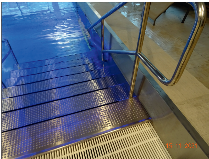
▼ Obr. 4 ● Bazén, schody i madla jsou bez koroze
