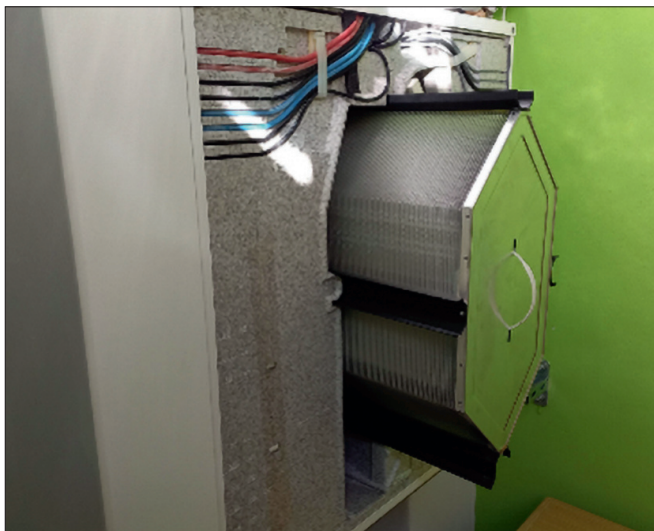
▲ Obr. 4 ● Rekuperační výměník
