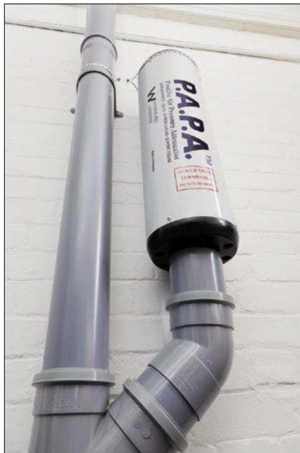
▲ Obr. 7 ● Omezovač přetlaků P.A.P.A. (zdroj: Studor)
