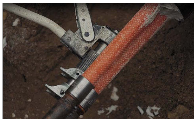
▲ Obr. 2 ● Lisování spojů plastového potrubí bez expanze
