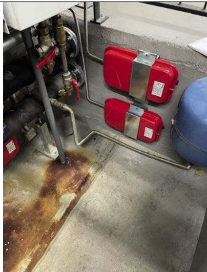
▲ Obr. 6 ● Svod vody od pojistného ventilu k podlaze kotelny a zanedbané expanze kotlů bez tlaku na vzduchové straně
