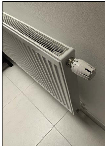
▲ Obr. 1 ● Otopné těleso s bočním napojením na rozvod
