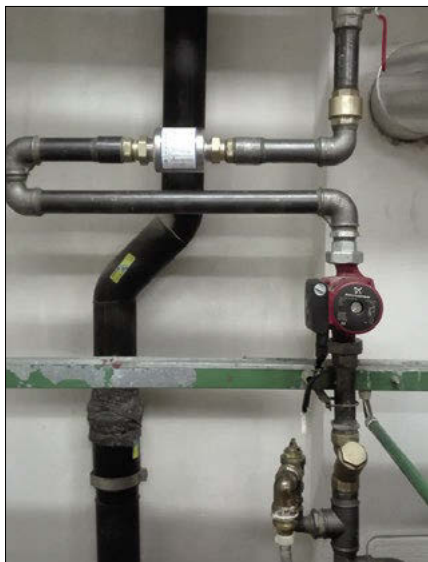
▲ Obr. 12 ● Aplikace zařízení pro fyzikální úpravu vody (zdroj: Aquatechnology)
