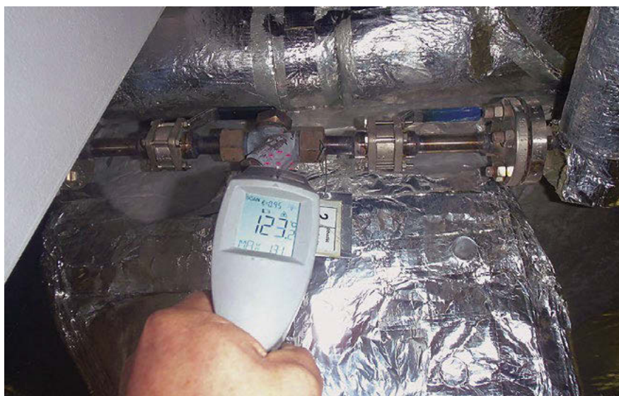
▼ Obr. 5 ● Měření povrchové teploty na filtru a odvaděčích kondenzátu
