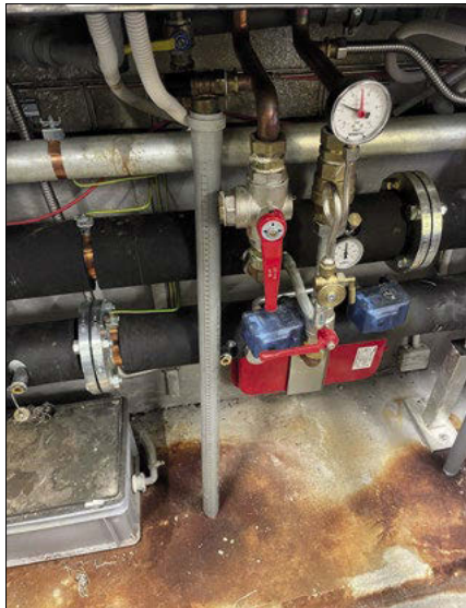
▲ Obr. 6 ● Svod vody od pojistného ventilu k podlaze kotelny a zanedbané expanze kotlů bez tlaku na vzduchové straně
