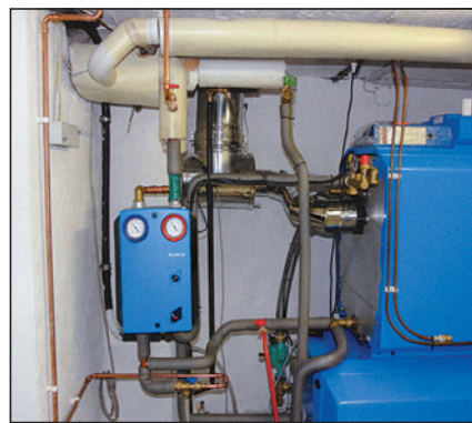
Obr. 6 Aktivní tlumič hluku v zabudovaném stavu
