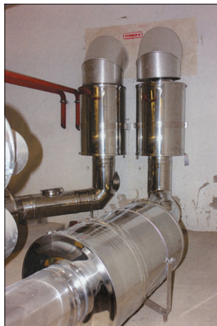
Obr. 8 TTS tlumič v zabudovaném stavu
