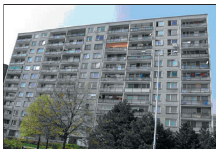
Obr. 2 Typický panelový dům VVÚ-ETA Praha [4]
