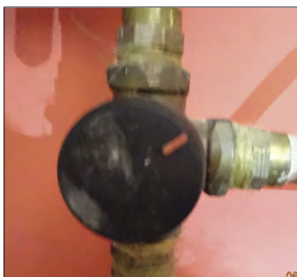
▲ Obr. 3 ● Termostatický směšovací ventil
