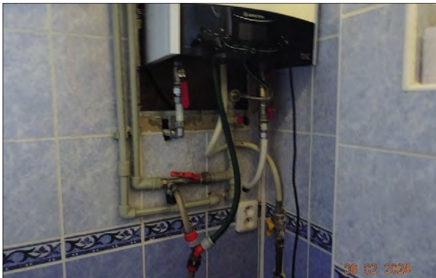
▲ Obr. 2 ● Závěsný plynový kotel
