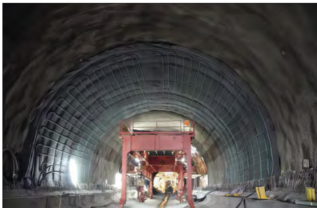
▲ Obr. 2 ● Instalace potrubí pro získání geotermální energie v tunelu Stuttgart-Fasanenhof v Německu, Foto: Stuttgarter Straßenbahnen
