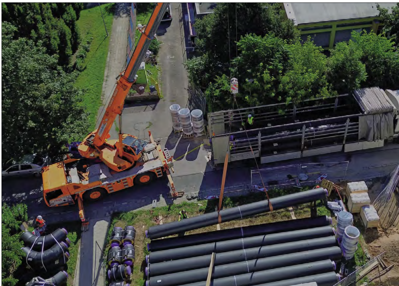
▲ Obr. 6 ● U projektu Brno – Sovinec, který je přípravou na napojení tepla z JE Dukovany, jsme použili ocelové předizolované potrubí dimenze DN500
