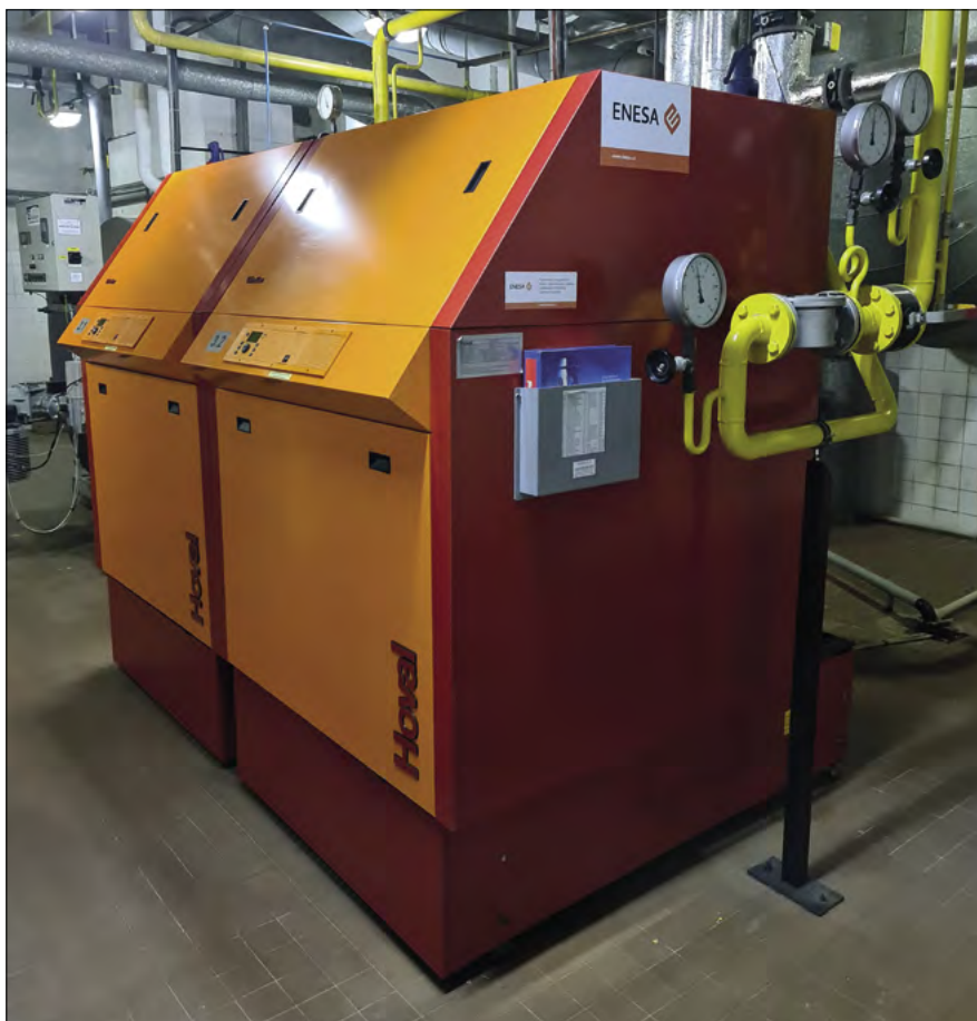
▲ Obr. 4 ● Dvojice kotlů Hoval nahradila jeden z původních kotlů Buderus
