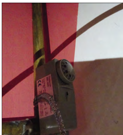
▲ Obr. 4 ● Termostat ovládací chod oběhového čerpadla
