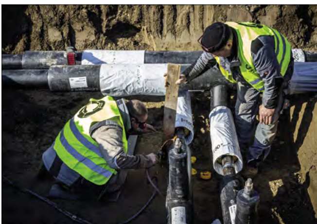
▲ Obr. 3 ● Pro napojení bratislavského projektu Nový Ružinov na centrální zásobování tepla použila společnost NRG flex potrubí NRG RADPOL s technologií difuzní bariéry. Díky tomu se výrazně sníží provozní ztráty v potrubí (foto JAGA, Miro Pochyba)
