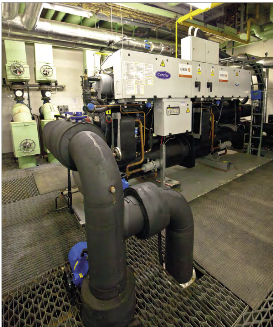
▲ Obr. 2 ● Tepelné čerpadlo / chladicí jednotka Carrier
