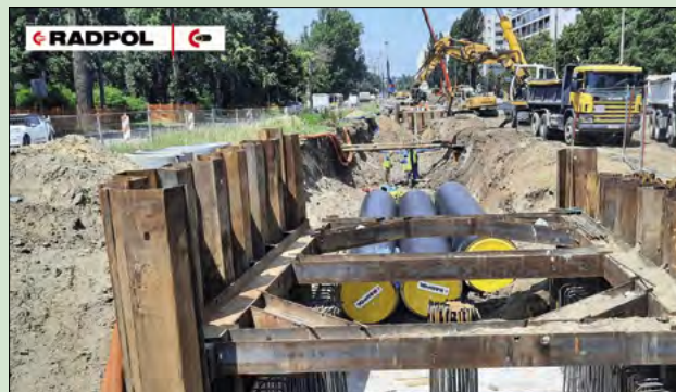
▲ Obr. 10 ● Výstavba nové tramvajové tratě ve Varšavě – u tohoto náročného projektu se použila ocelová potrubí v rozmezí od DN80 až po DN 1100 v celkové délce 8280 m od firmy RADPOL PIPES, kterou na slovenském a českém trhu zastupuje společnost NRG flex
