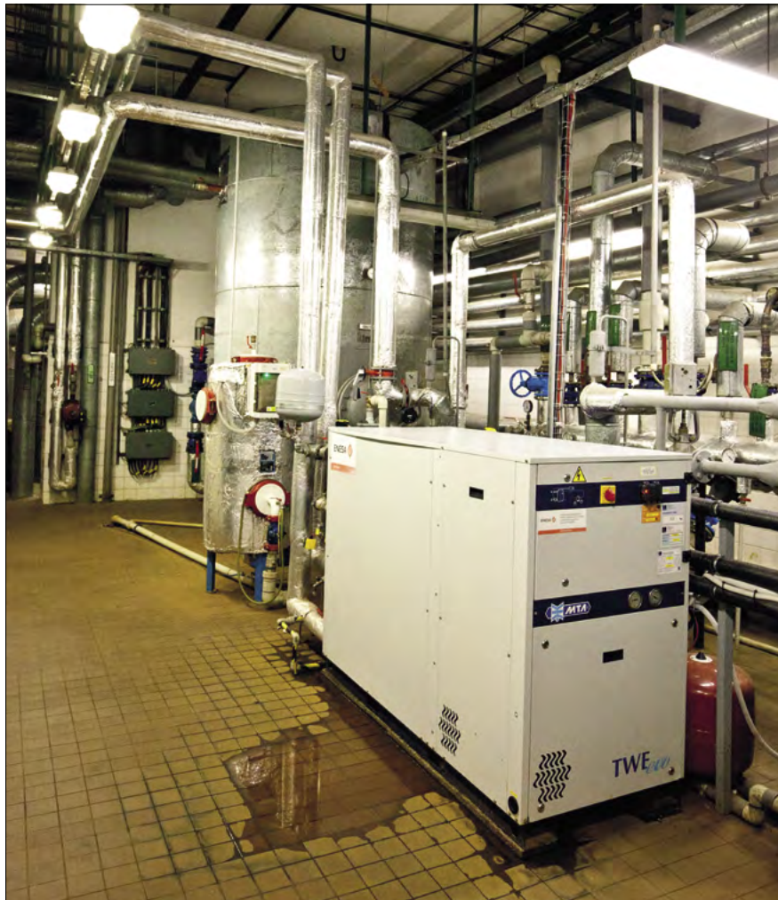
▼ Obr. 1 ● Tepelné čerpadlo Daikin TWE MTA
