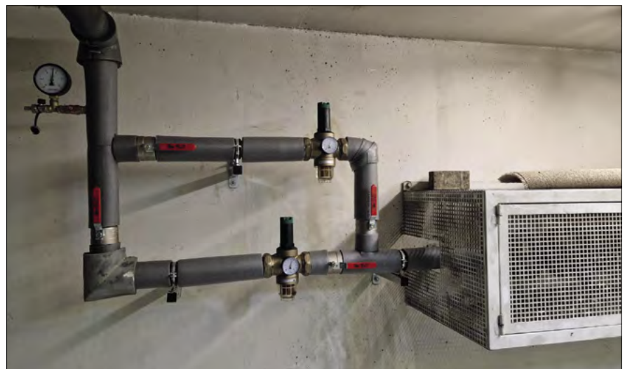
▼ Obr. 5 ● Nově osazené redukční ventily za vodoměrovou sestavu u vodovodní přípojky
