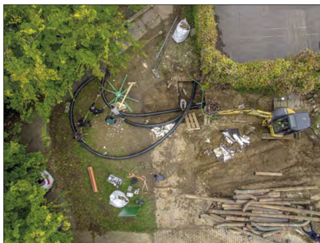
▼ Obr. 5 ● Při instalaci potrubí mohou být zásahy na pozemcích a omezení minimální – ukázali jsme to na projektu vnitrobloku Račianska – Kominárska v Bratislavě, kde jsme flexibilní plastové potrubí dimenze d160/DA255 vtažovali do stávajících kolektorů, obyvatelům vnitrobloku jsme takto zachovali park i hřiště
