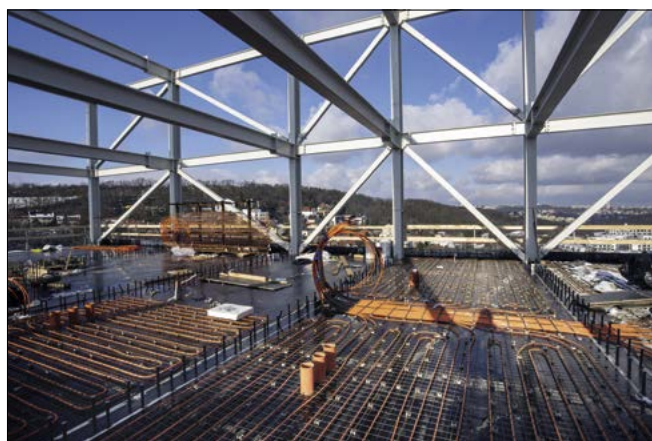
▼ Obr. 6 ● Systém BKT na stavbě knihovny Univerzity Karlovy
