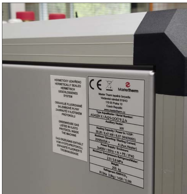
▲ Obr. 8 ● Trvalost výrobního štítku zajišťuje bezpečnostní samolepicí etiketa z polyesteru
