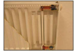
▲ Obr. 14 ● Termostatická hlavice umístěná pod OT (vlevo), vedle OT (uprostřed), uvnitř OT (vpravo)
