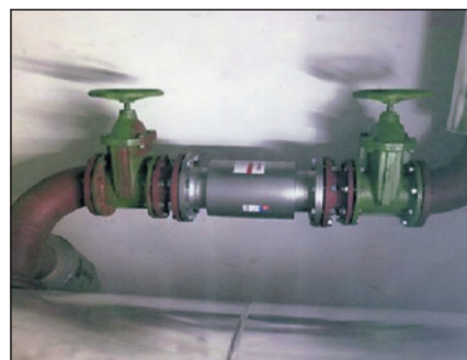
▼ Obr. 3 ● Aplikace zařízení pro fyzikální úpravu vody s přírubami
