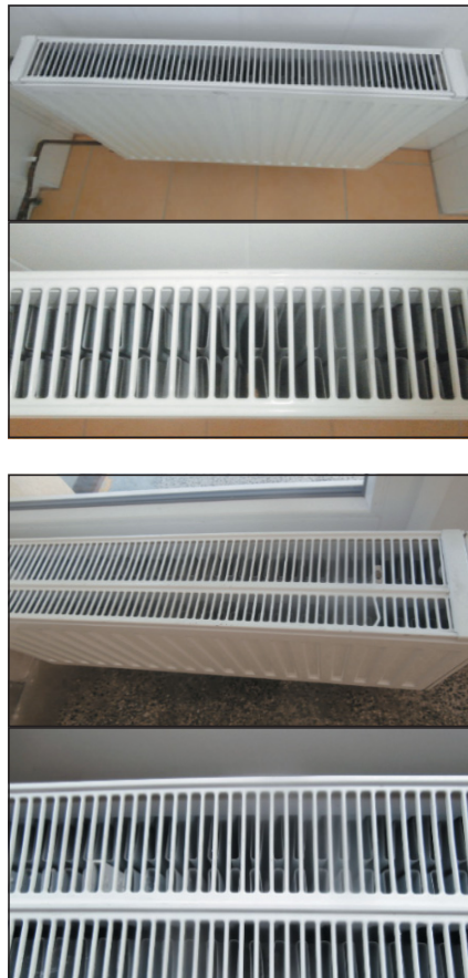
▲ Obr. 9 ● Otopné těleso dvoudeskové (nahore) a třidedkové (dole)
