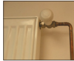
▲ Obr. 14 ● Termostatická hlavice umístěná pod OT (vlevo), vedle OT (uprostřed), uvnitř OT (vpravo)
