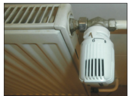
▼ Obr. 15 ● Termostatická hlavice nastavená na protimrazovou ochranu (vlevo), na nejvyšší výkon (vpravo)
