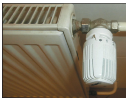
▼ Obr. 15 ● Termostatická hlavice nastavená na protimrazovou ochranu (vlevo), na nejvyšší výkon (vpravo)
