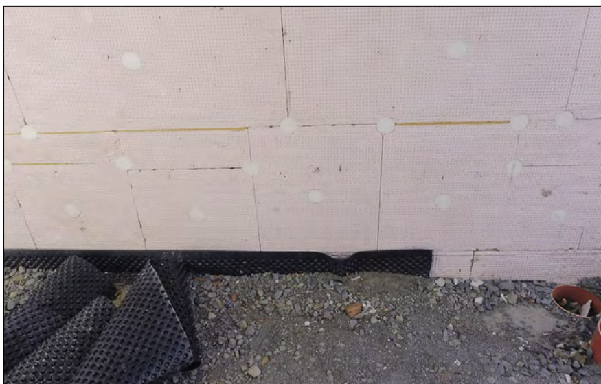
▼ Obr. 4 ● Polystyren EPS perimetr – zateplení soklu (zdroj: autor)
