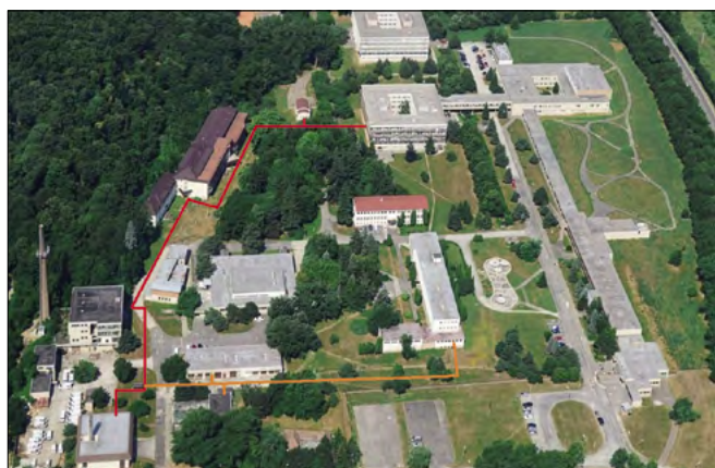
▼ Obr. 2 ● Rekonstrukce rozvodů tepla pro psychiatrickou nemocnici
