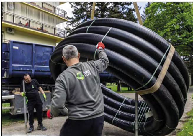
▲ Obr. 4a ● Navinuté ohebné trubky na kotouči
