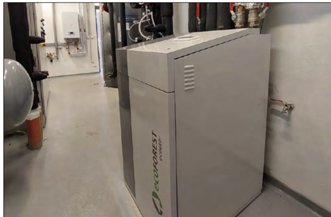
▲ Obr. 1 ● Tepelné čerpadlo ecoGEO s výkonem 23 kW a zabudovaným pasivním i aktivním chlazením
