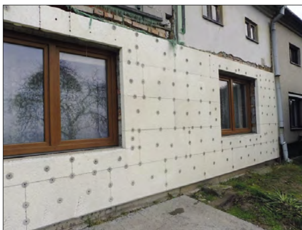
▼ Obr. 3 ● Fasáda RD zateplená bílým polystyrenem (zdroj: autor)
