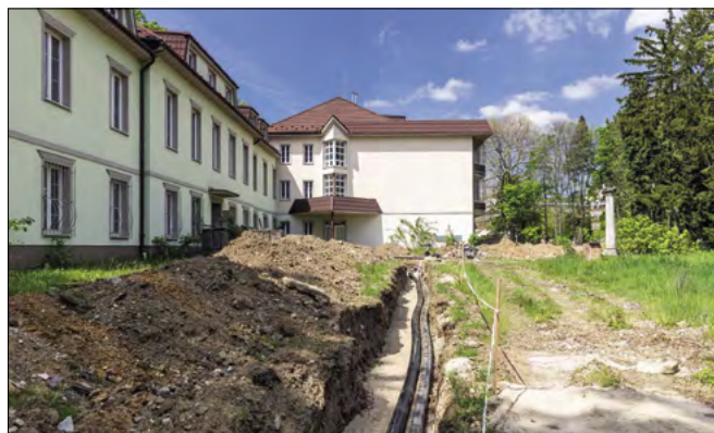
▲ Obr. 1 ● Předizolované plastové potrubí pro Psychiatrickou nemocnici Philippa Pinela Pezínok
