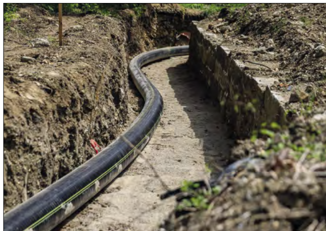
▲ Obr. 4b ● Kopírování terénu bez použití kolen
