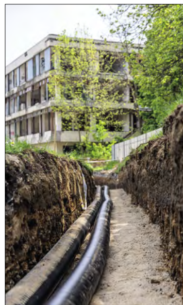
▲ Obr. 3 ● Realizace navržených předizolovaných trubek v areálu psychiatrické nemocnice
