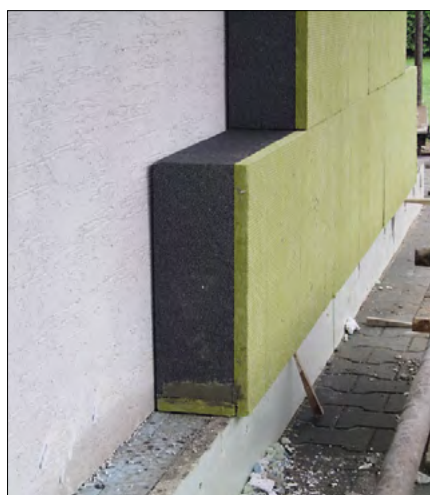
▲ Obr. 5 ● Sendvičová izolační deska Twinner (zdroj: imaterialy.cz)
