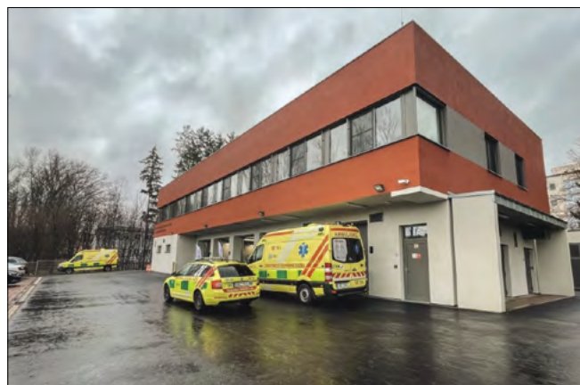
▲ Obr. 2 ● Budova ZS Boskovice využívá pasivní a aktivní chlazení z vrtu, poháněné vlastní elektřinou z FVE
