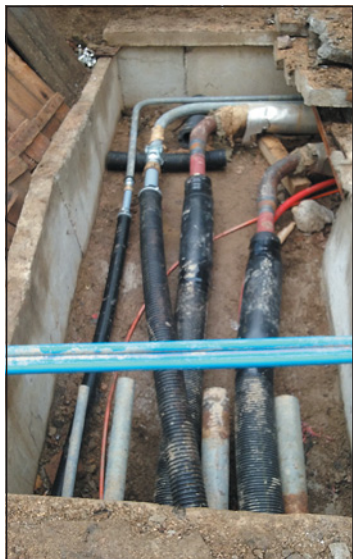
▲ Obr. 4 ● Na zdravé části původního ocelového potrubí UT byly navazovány varné přechody ocel/PB v kanále (na obrázku) i v domě pod armaturami
