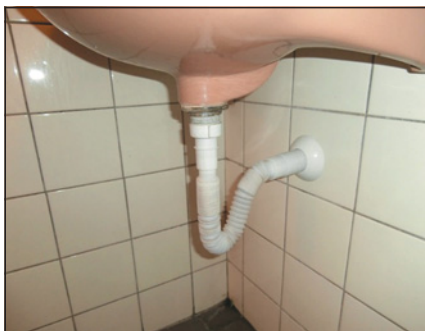
▲ Obr. 3a ● Připojení flexi hadic s hladkým koncem a plastovou maticí (starší typ)
