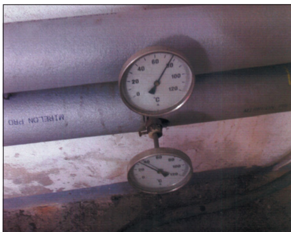
▼ Obr. 3 ● Rozdíl teplot mezi přívodem do rozdělovače a odvodem ze sběrače
