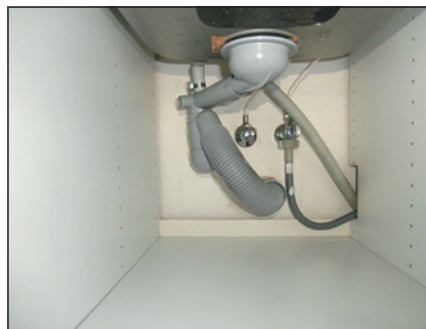
▲ Obr. 9 ● Montáž zápachové uzávěrky dřezu ve vestavné skříňce s napojením na odpad hadicí
