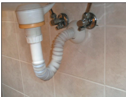
▼ Obr. 3b ● Připojení flexi hadic s hladkým koncem a plastovou maticí (novější typ)
