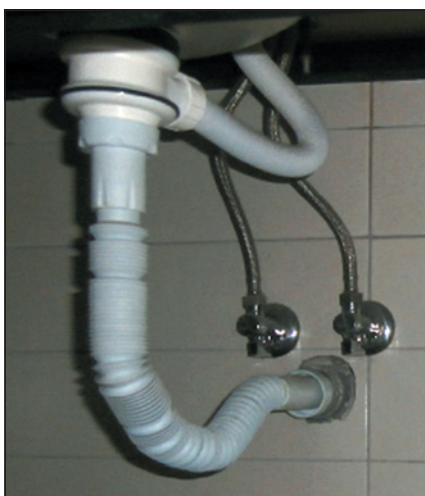
▲ Obr. 8 ● Chybným natvarováním hadice nevznikla potřebná hloubka vodního uzávěru
