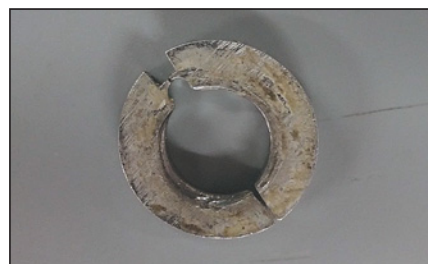
▼ Obr. 5 ● Stav objímky po demontáži potvrzuje správnost úvah o příčině a průběhu havárie – viz foto. Na vnitřní hraně je vidět deformaci po zápichu dřívku ventilu
