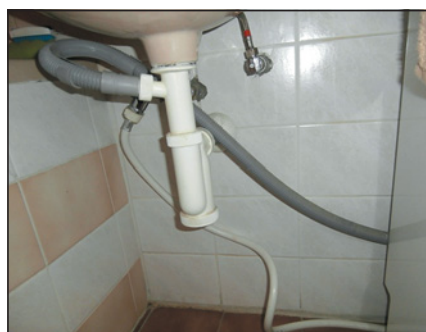
▲ Obr. 10 ● Připojení pračky k sifonu umyvadla flexibilní hadicí uchycenou do pevného oblouku
