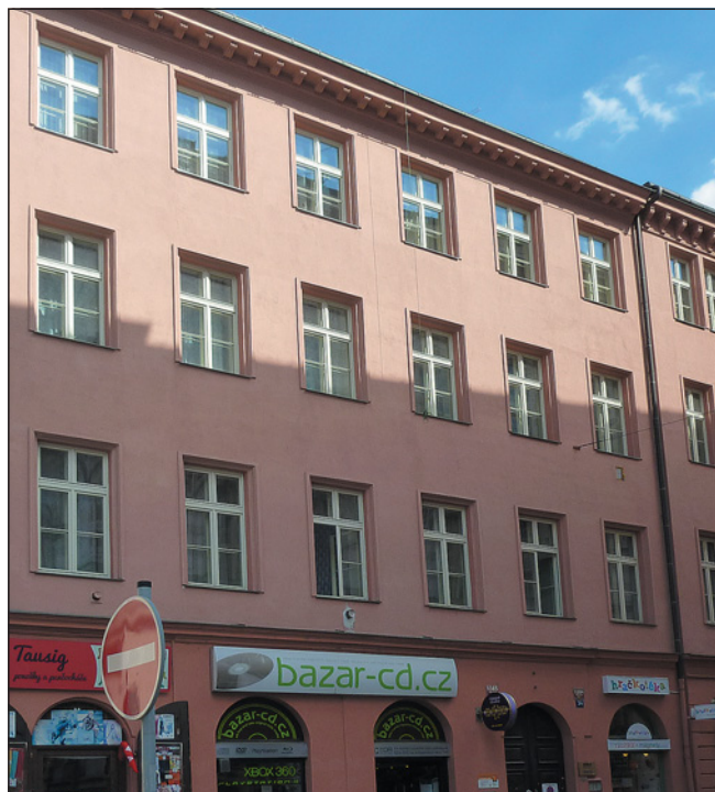
▼ Obr. 2 ● Zrekonstruovaný bytový dům na Praze 1 s 12 nájemními byty
