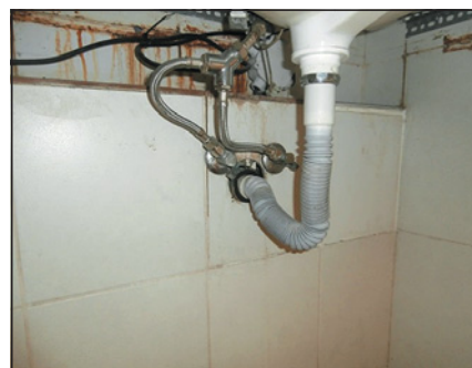
▲ Obr. 5 ● Připojení flexi hadic s hladkým koncem a kovovou maticí – nedostatečná hloubka vodního uzávěru, možnost odsátí vodní uzávěrky a úniku zápachu
