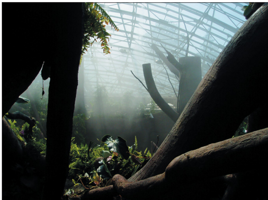
▲ Obr. 2 ● Pavilon indonéské džungle – otopné trubky jako součást střechy, foto: Ing. arch. Pavel Ullmann, AND
