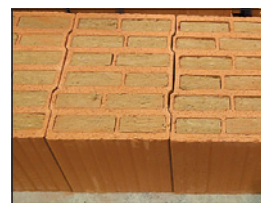
▲ Obr. 1 ● Termoizolační cihly; vlevo s velkou nosností pro patrové budovy; vpravo s menší nosností pro přízemní budovy nebo přičky
