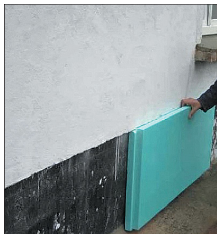
▲ Obr. 6 ● Izolace styrodurem těsně nad vozovkou a polystyrenem nad ním
