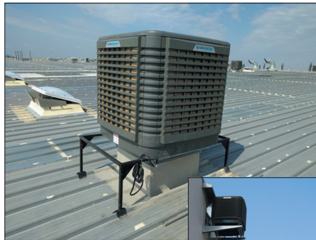
▲ Obr. 4 ● Ukázka instalace adiabatické jednotky na střeše výrobní haly
