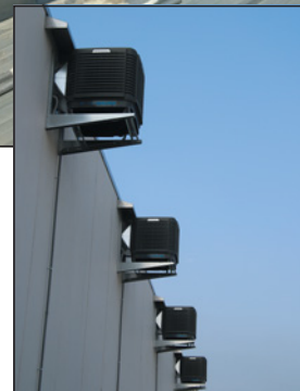
▲ Obr. 4 ● Ukázka instalace adiabatické jednotky na střeše výrobní haly
