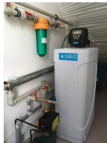
Obr. 2 Kabinetní typ zařízení pro rodinný dům, včetně rozšíření o UV sterilizátor
