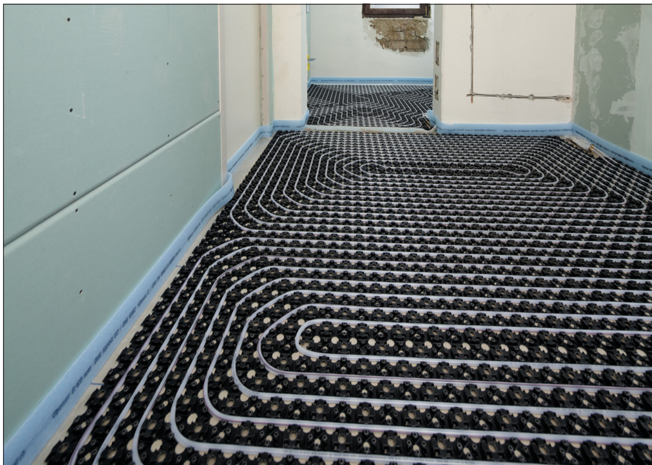
▼ Obr. 1 ● Instalovaný systém Uponor Minitec připravený pro zalití
