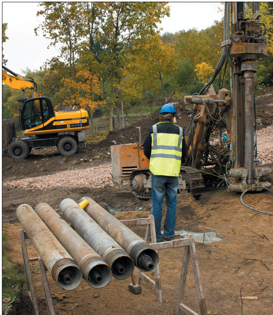
▲ Obr. 1 ● Vrtání geotermálních vrtů se sondami GEROtherm
