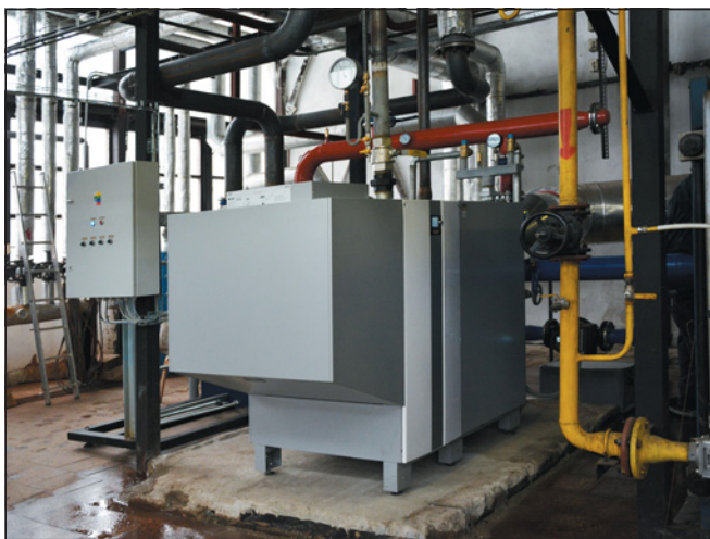
▲ Obr. 2 ● Stacionární kondenzační kotel WOLF MGK-2 s výkonem 1000 kW má minimalizovanou instalační plochu, min. zastavěná plocha pouhých 6,9 m 2
