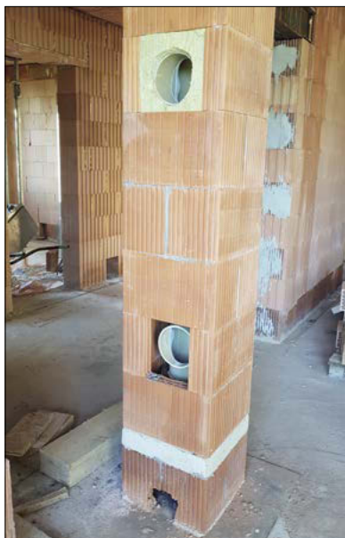
▲ Obr. 1 ● Komín připravený pro napojení přívodu spalovacího vzduchu pod čistou podlahou
