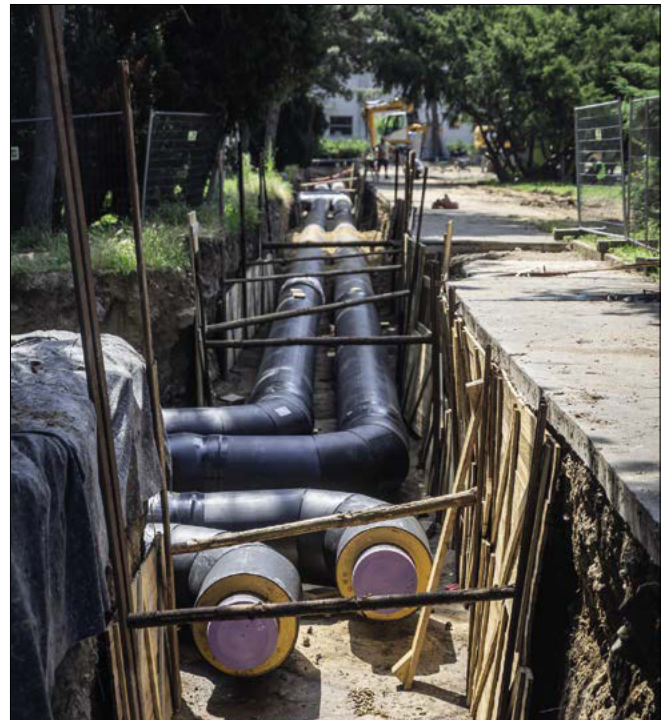
▲ Obr. 4 ● Vtahování předizolovaného plastového potrubí pod křižovatkou
