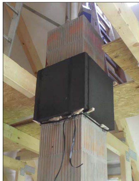
▲ Obr. 3 ● Parotěsný prostup na komínovém tělese v místě budoucí izolované stropní konstrukce
