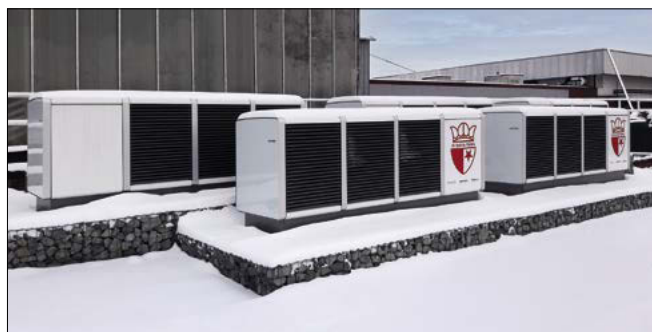
▲ Obr. 2 ● Tepelná čerpadla HELIOTHERM v designovém provedení se zakrytými výparníky a ventilátory
