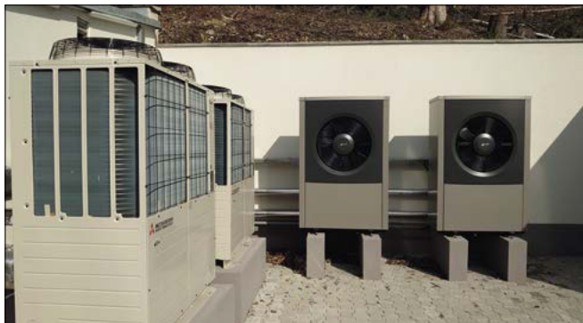
▲ Obr. 1 ● Kombinace vysokoteplotních čerpadel Q ton pro teplou vodu a IVT pro vytápění
