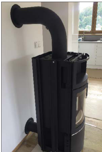
▲ Obr. 2 ● Kamna napojená na komín kouřovodem i přívodem vzduchu z boku komína
