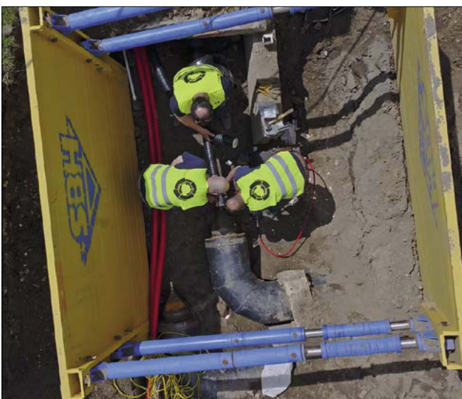
▼ Obr. 6 ● Realizování napojení nových potrubních rozvodů
