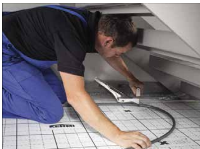
▲ Obr. 3 ● Použití sponkovacího přístroje Tacker mini pro upevnění Tacker spon v poloze vkleče
