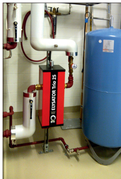
► Obr. 6 ● Zařízení ELYSATOR Trio 25 s funkcí stálé kontroly, zdroj: ELYSATOR
