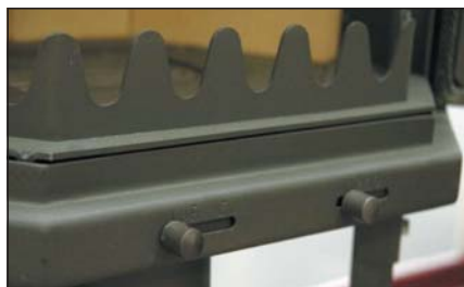
Obr. 9 Příklad ovládání klapky pro přívod primárního vzduchu
