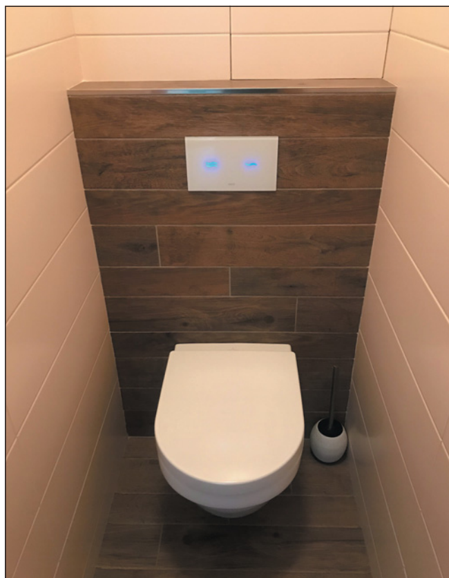
▲ Elektronický dotykový splachovač WC s elektronikou ALS do montážního rámu SLR 21, barva skla bílá, podsvícení modré, 24 V DC
