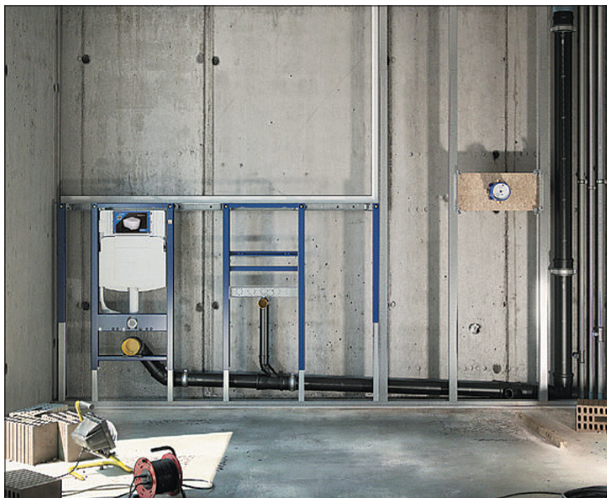
▲ Obr. 11 ● Montáž záchodové mísy a dalších zařizovacích předmětů s použitím předstěnových montážních prvků
