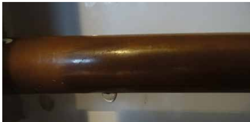
▼ Obr. 1 ● Kapka na měděné trubce rozdělovače
