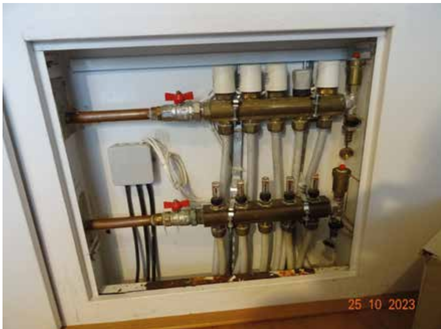
▲ Obr. 2 ● Rozdělovač a sběrač
