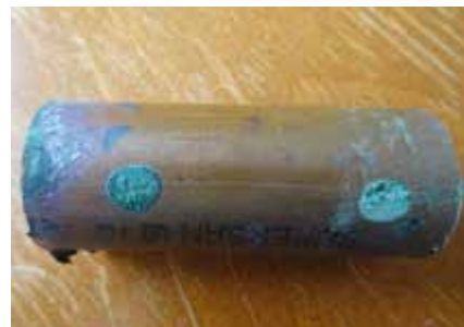
▲ Obr. 3 ● Netěsnosti vznikají ve vzdálenostech cca 4 cm
