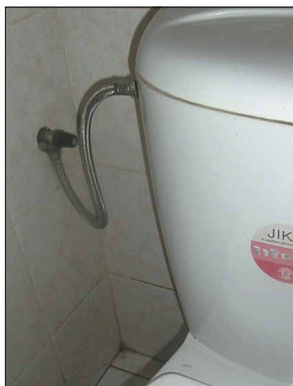
▲ Obr. 24 ● Rohový ventil bez krytky
