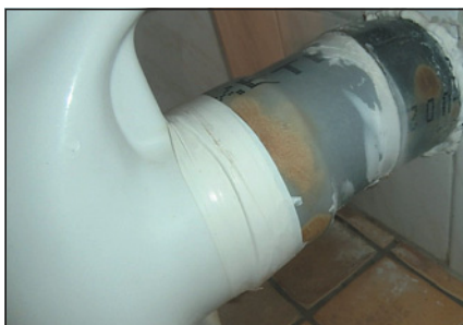
▲ Obr. 21 ● Trubka z PVC utěsněná páskou
