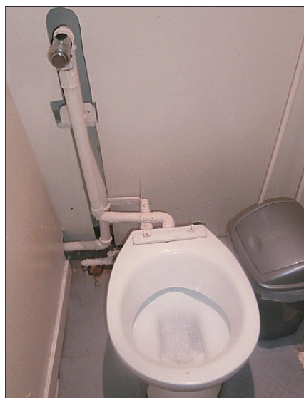
▲ Obr. 23 ● Tlakový splachovač je mimo střed mísy, kde navíc chybí sedátko
