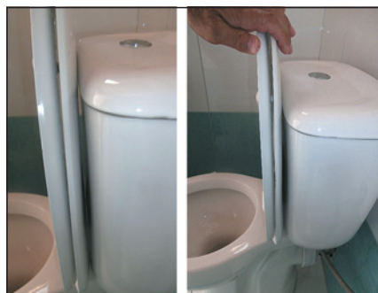
▲ Obr. 16 ● Sedátko je nutno držet aby se samovolně nesklopilo
