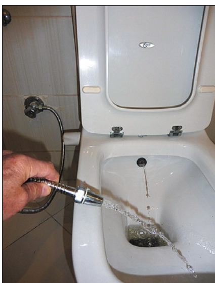
▲ Obr. 15 ● Záchodová mísa se dvěma sprškami
