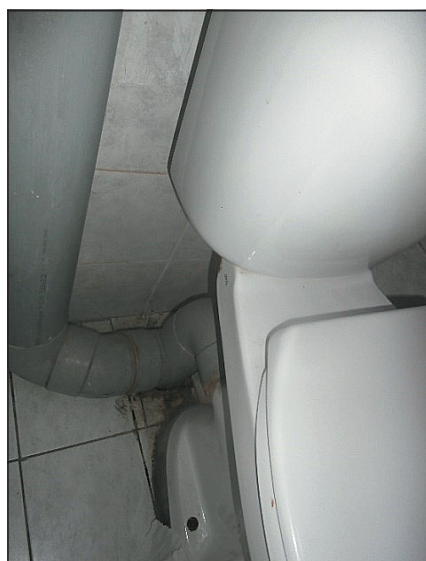
▲ Obr. 17 ● Propojení odpadního potrubí s dešťovým
