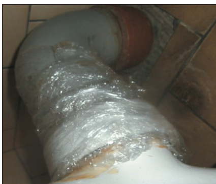
▲ Obr. 22 ● Dodatečné utěsnění spoje omotáním fólií
