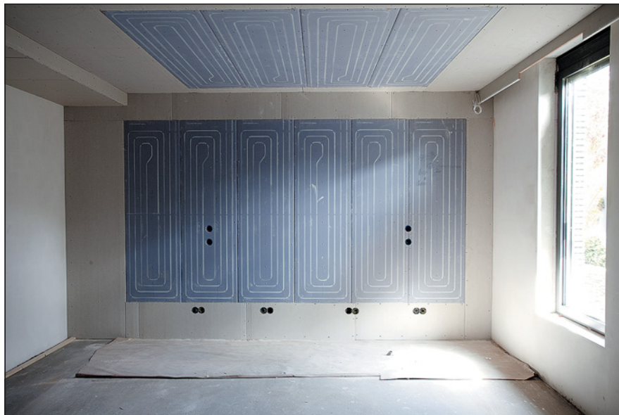
◀ Obr. 1 ● Systém Renovis instalovaný ve stěně i stropu
