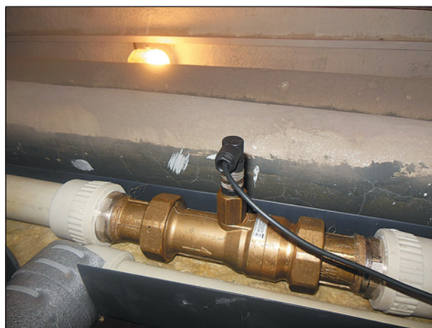
◀ Obr. 1 ● Průtokoměr OPTIFLUX 1000 osazený za vodoměrem v bytovém domě v Bohumíně
