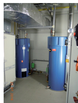
Obr. 4 Instalace kondenzačních zásobníkových ohřivačů vody Q7C-100-199 v průmyslovém areálu ZF Staňkovs.r.o.
