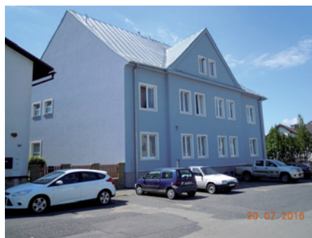
Obr. 2 Zdravotní středisko Holýšov – instalace Q7C
