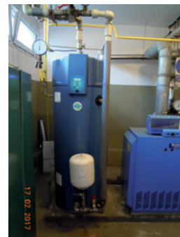
Obr. 3 Rekonstrukce bytového domu s požadavkem na centrální dodávku teplé vody; jako nejlepší řešení byl zvolen kondenzační zásobníkový ohřivač vody Q7C-100-199
