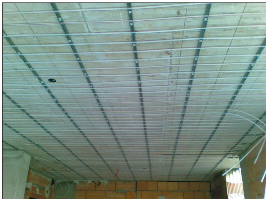
▲ Obr. 3. ● Instalovaný systém Uponor Plaster před zakrytím omítkou na stropní konstrukci
