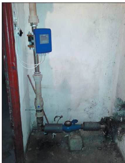
◀ Obr. 1 ● Průtokoměr OPTIFLUX 1000 osazený za vodoměrem v bytovém domě v Bohumíně
