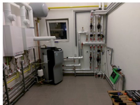
Obr. 1 Ukázka instalace kondenzačního zásobníkového ohřivače vody IR-12-160 v kancelářské budově po kompletní rekonstrukci budovy
