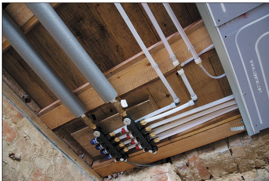
◀ Obr. 2 ● Pátevní rozvod pro Renovis s rozdělovačem Vario PLUS
