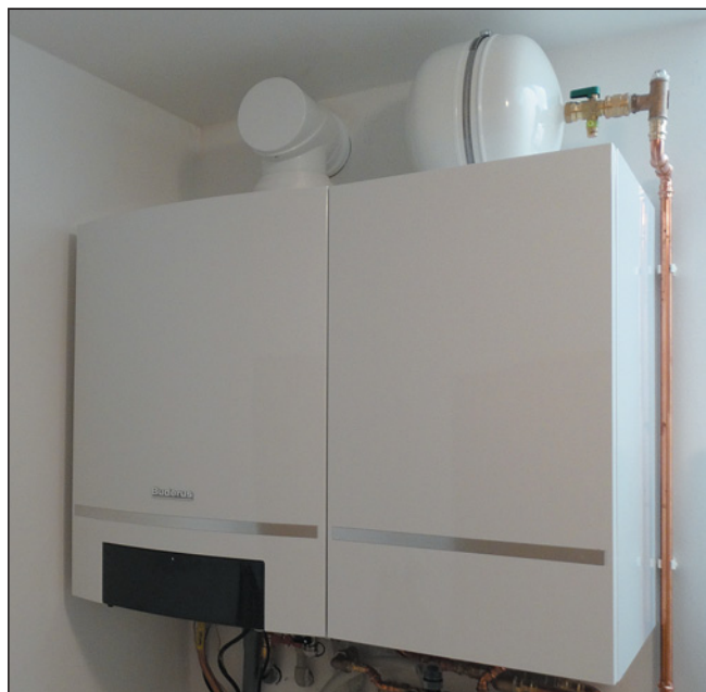
Obr. 2 Kotel umístěný v zádveři
