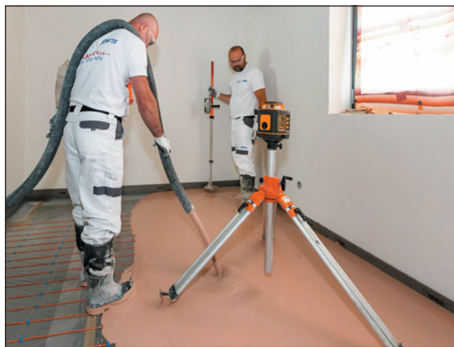
▲ Realizace anhydritové podlahy
