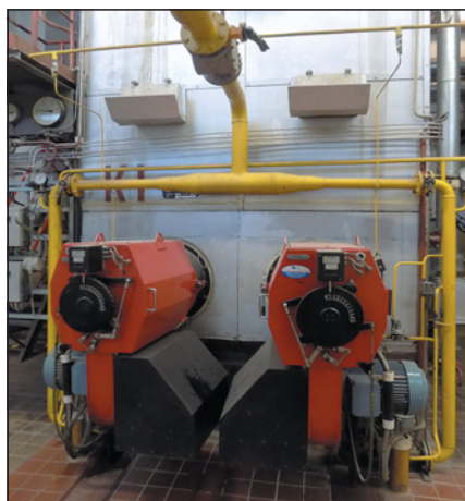
▲ Obr. 3 ● Dvoupalivové hořáky na kotli K1
