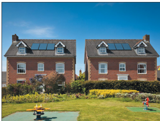
▲ Obr. 1 ● Příklad instalace kolektorů Logasol SKS5.0 na rodinných domech v Německu
