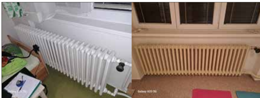
▼ Obr. 2 + 3 ● Provedení původní instalace tak, aby radiátory pokrývaly celou plochu pod okny
