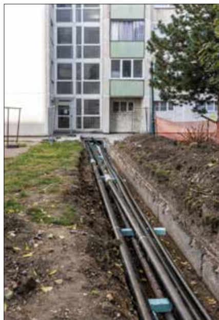
▼ Obr. 2 ● Výměna rozvodů Bratislava Petržalka, foto: Miroslav Pochyba – JAGA
