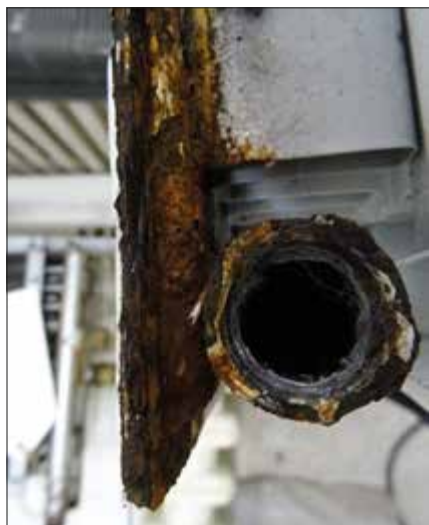
▼ Obr. 1 ● Připojovací potrubí a spodní část deskového otopného tělesa
