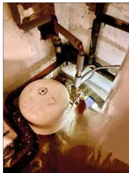
▲ Obr. 6 ● Napojení zpátečky TČ a expanzní nádoby
