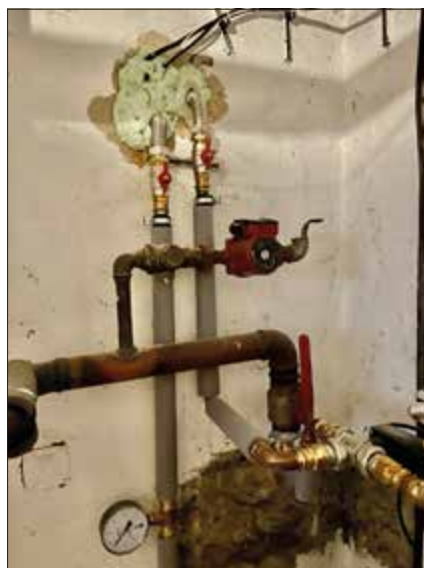
▲ Obr. 5 ● Napojení přívodu TČ na starou otopnou soustavu
