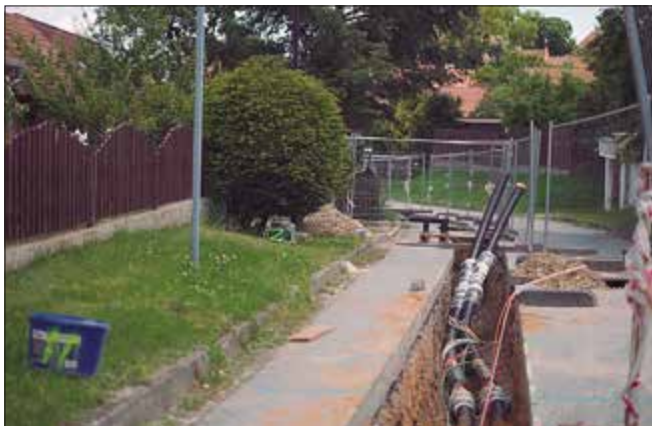
▲ Obr. 4 ● Výkopové práce v obci Dukovany
