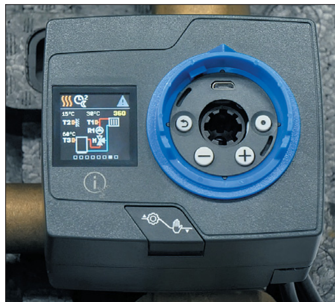
▼ Obr. 3 ● Regulátor Proclick s ovladacími tlačítky a přehledným OLED displejem
