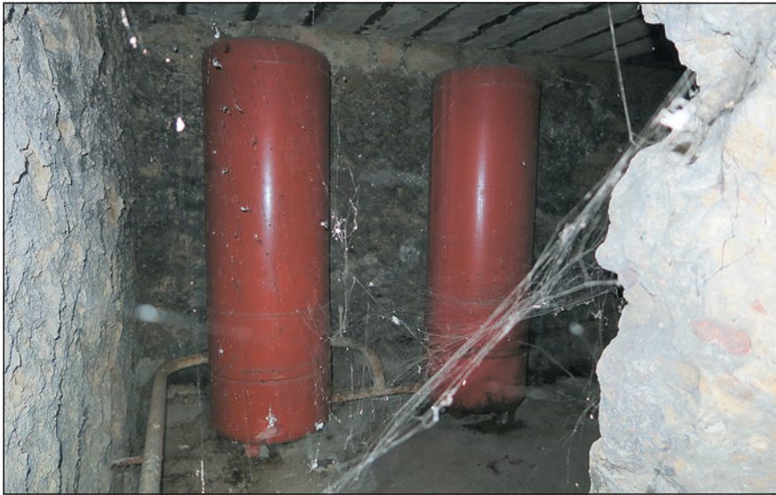
▲ Obr. 2 ● Expanzní nádoby bez manometru a kombinované armatury ke zkoušení plynové části expanze
