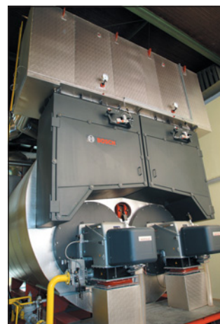
▲ Obr 4 ● Aplikace předehřevu vzduchu Bosch u dvouplamencového parního kotle Bosch typ ZFR-IE
