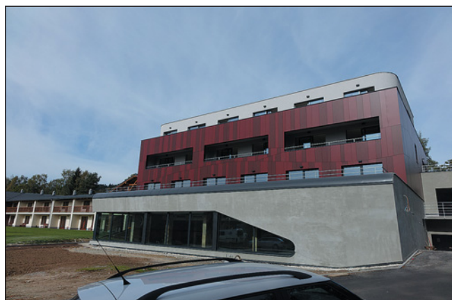
▲ Obr ● Moderní zdroj tepla a elektřiny je instalován v přízemí nově postavené budovy hotelu. Budova svým vzhledem symbolicky odkazuje na jachtařský sport, který na Lipno přitahuje mnoho fanoušků, pro jejichž ubytování jsou k dispozici řadové domy navazující na novou budovu zleva. Nejen jachtaři si chtějí pobyt u Lipna prožít co nejrozmanitěji. K tomu slouží celoročně provozovaný wellness a bazénové aktivity.
