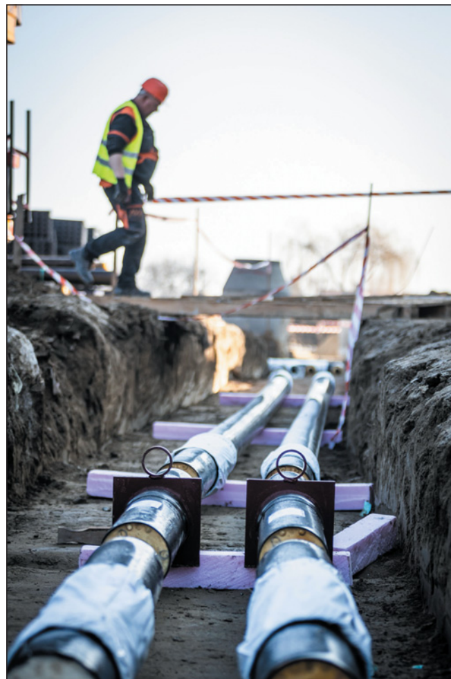
▼ Obr. 5 ● Nový přípojný teplovod v Ružinově realizovaný předizolovaným potrubím NRG RADPOL s difuzní bariérou (foto: Miroslav Pochyba, JAGA)
