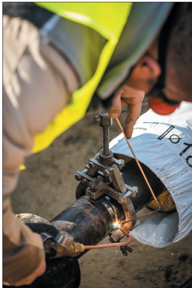
▼ Obr. 4 ● Ocelové předizolované potrubí svařované každých 12 m (foto: Miroslav Pochyba, JAGA)
