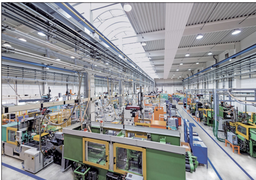
▲ Obr 3 ● Příklad modulárního systému panelů ve výrobní hale. Pro zvýšení efektivity sálavého výkonu Zehnder ZFP lze po obou stranách panelu nainstalovat sálavou clonu, která zvyšuje podíl sálání až na 88 % a tím maximální úsporu energie
