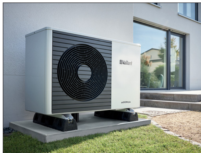
▲ Obr. 1 ● Instalace tepelného čerpadla aroTHERM plus ve venkovním prostoru
