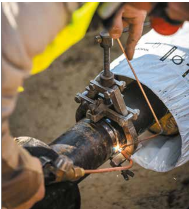
▲ Obr. 7 ● Ocelové předizolované potrubí svařované každých 12 m (foto: Miroslav Pochyba, JAGA)
