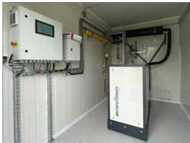
▲ Obr. 2 ● Mikrokogenerační jednotka NEOTOWER současně vyrábí 12,5 kW elektřiny a 27,6 kW tepla
