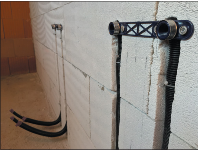
▲ Obr. 2 ● Osazení přípojů do zdí
