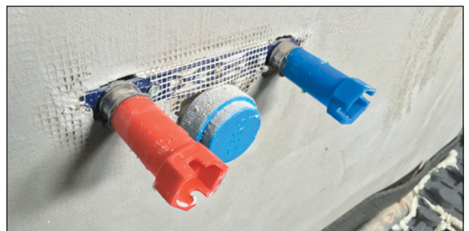
▲ Obr. 7 ● Připojení teplé vody od bojleru nejkratší trasou nad podlahovým vytápěním (bez izolací)
