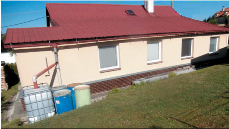
▲ Obr. 35 ● Nejjednodušší příklad zachycení srážkové vody ze střechy rodinného domu
