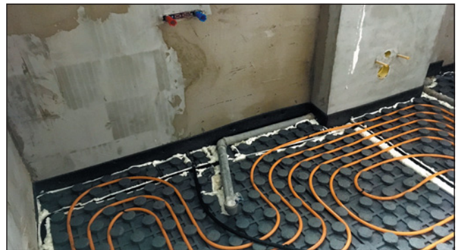
▲ Obr. 6 ● Finalizace koupelny před betonáží (teplá voda dimenze 17 mm bez izolací nad podlahovým vytápěním)
