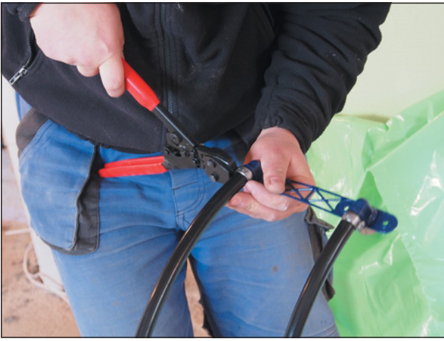
▲ Obr. 1 ● Lisování nástěnek
