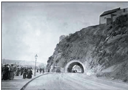
▲ Obr. 4 ● Před novostavbou Vyšehradského tunelu, duben 1907 (Sbírka Scheufler, www.scheufler.cz; foto: R. Bruner-Dvořák)
