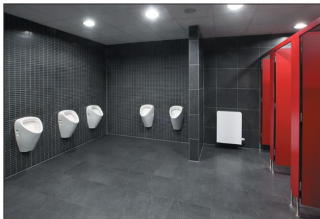
▲ Obr. 2 ● Realizace pisoárů Golem s radarovým splachovačem na WC v divadle Uffo v Trutnově
