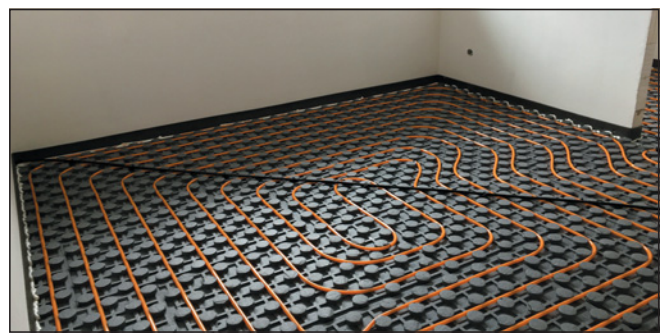
▲ Obr. 7 ● Připojení teplé vody od bojleru nejkratší trasou nad podlahovým vytápěním (bez izolací)
