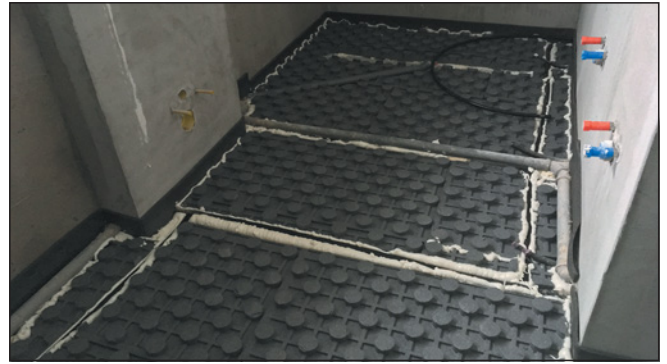
▲ Obr. 5 ● Koupelna před instalací podlahové trubky
