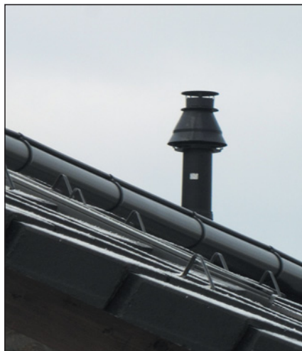
▼ Obr. 2 ● Vyvedení plastového potrubí odolávající UV záření nad střechu domu
