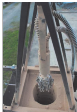
◀ Obr. 11 ● Úprava komínového průduchu komínovou frézou
