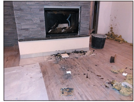
▲ Obr. 2 ● Výbuch výměníku krbové vložky
