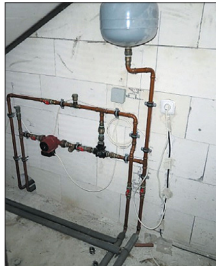
▲ Obr. 1 ● Okruh krbové vložky s výměníkem
