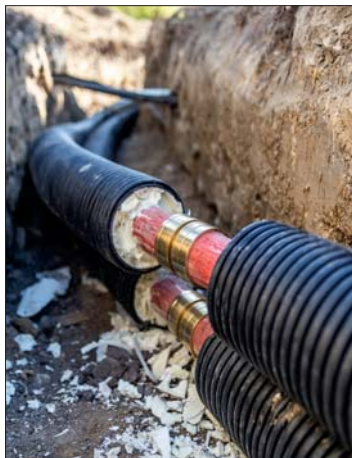
▲ Obr. 4 ● Detail lisovaného spoje u předizolovaného plastového potrubí (foto: JAGA Miro Pochyba)
