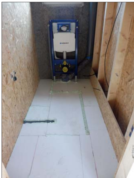
▲ Obr. 2 ● Osazení modulu závěsného WC na stěně
