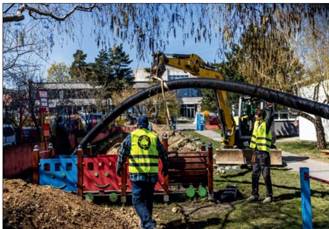
▲ Obr. 3 ● Napojení nového flexibilního předizolovaného potrubí (foto: JAGA Miro Pochyba)
