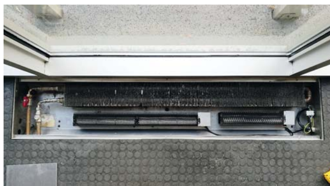
▼ Obr. 2 ● Oprava podlahového konvektoru a výměna ventilátoru – po servisu
