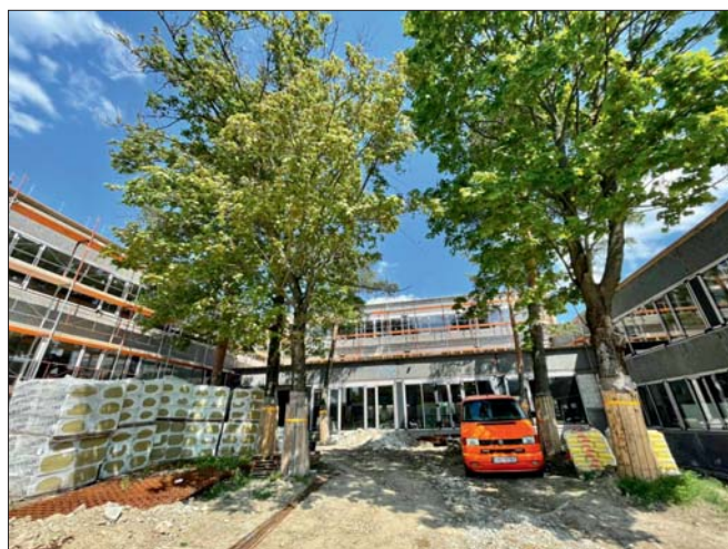
▼ Obr. 2a; 2b ● Probíhající rekonstrukce ZŠ Plicková [1]
