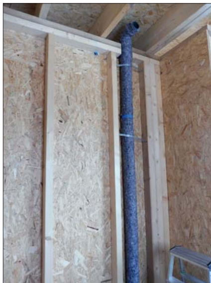
▲ Obr. 4 ● Vedení odpadního izolovaného potrubí dřevěnou stěnou
