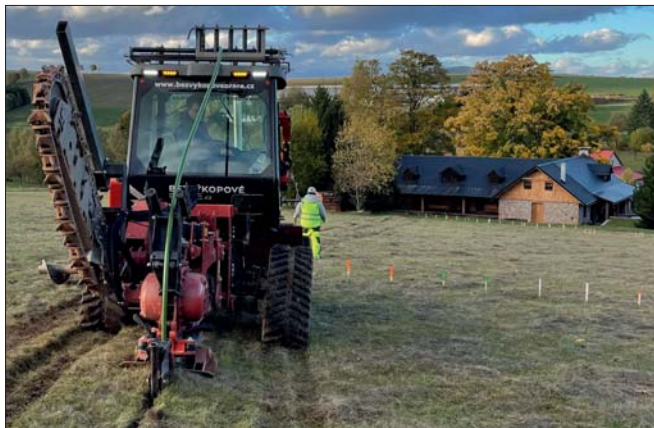
▲ Obr. 1 ● Pokládka kolektoru zemního tepelného čerpadla
