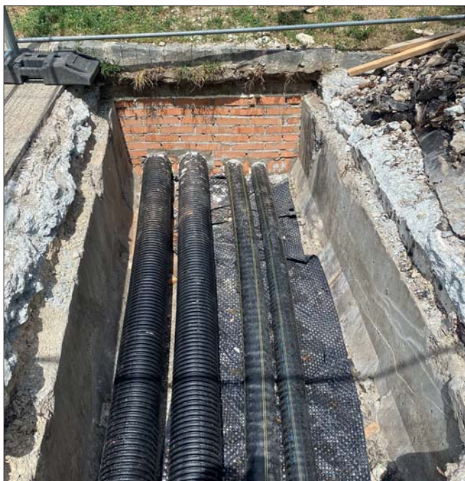
▲ Obr. 8 ● Umístění předizolovaného potrubí v projektu Kramáry
