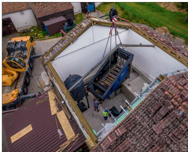
▼ Obr. 6 ● Kotelna na biomasu, instalace nového biokotle
