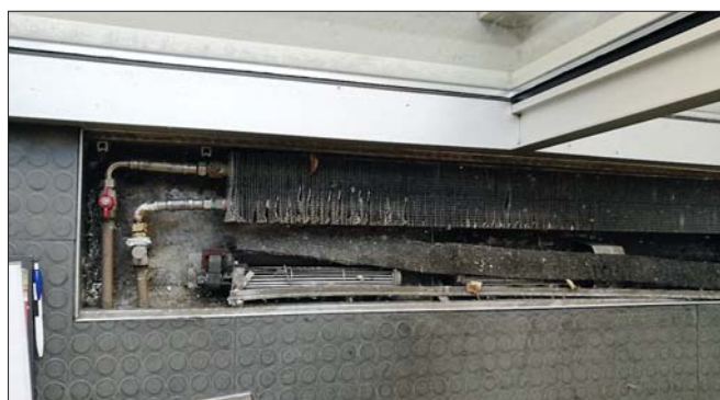
▼ Obr. 1 ● Oprava podlahového konvektoru a výměna ventilátoru – před servisem
