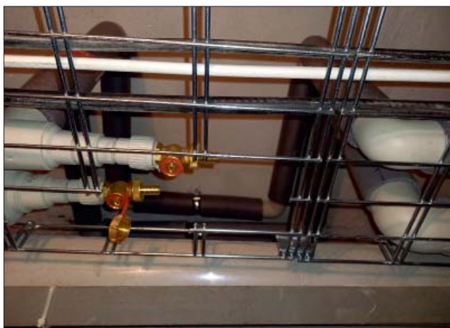
▲ Obr. 15*) ● Kompenzátor v samostatném dilatačním úseku potrubí
