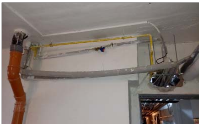
▼ Obr. 7 ● Potrubí pod stoupačkami je prohnuté
