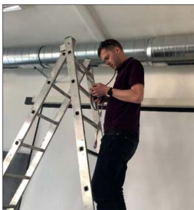
▼ Obr. 1 ● Měření tlakové difference
