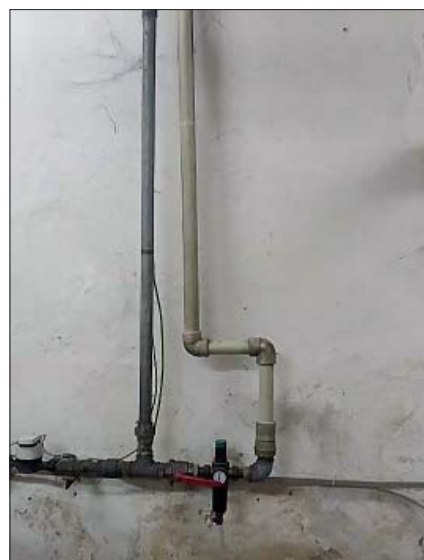
▼ Obr. 9 ● Napojení požárního vodovodu za vodoměrovou sestavou bez objímek na svislé části potrubí
