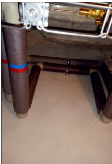
▼ Obr. 16*) ● Kompenzátor v samostatném dilatačním úseku potrubí
