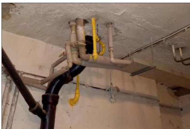
▼ Obr. 7 ● Potrubí pod stoupačkami je prohnuté
