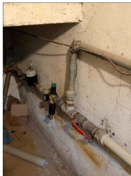
▼ Obr. 9 ● Napojení požárního vodovodu za vodoměrovou sestavou bez objímek na svislé části potrubí
