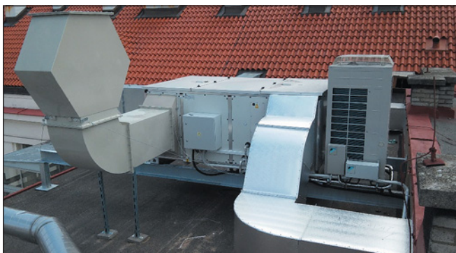
▲ Obr. 5 ● Jednotka DUOVENT® Compact DV 6000 DI2 DX KL G4/G4 DCOP OP v provedení s příslušenstvím ROOFPACK-A
