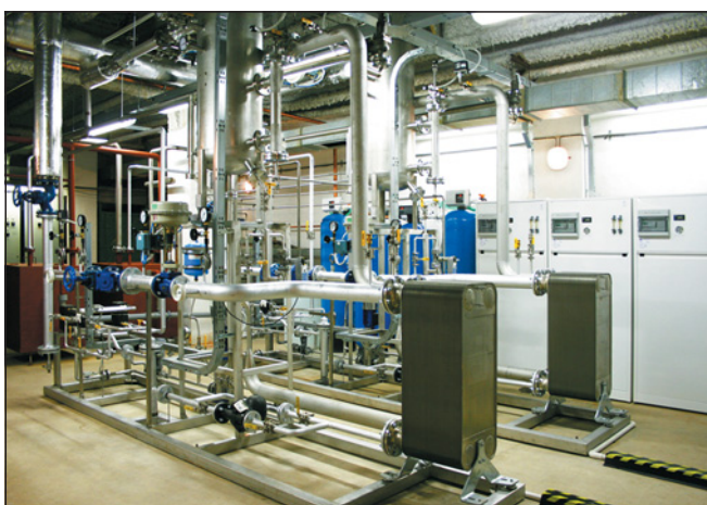
▲ Obr. 5 ● Ukázka z instalace zařízení STEAMEX
