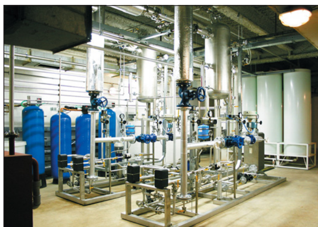
▲ Obr. 7 ● Zařízení na výrobu čisté páry STEAMEX ve FN Brno-Bohunicích
