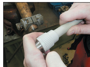
▲ Obr. 3 ● Spojování trubek vnitřního vodovodu z plastového potrubí
