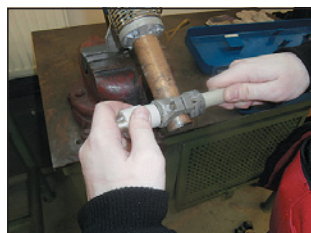
▲ Obr. 3 ● Spojování trubek vnitřního vodovodu z plastového potrubí
