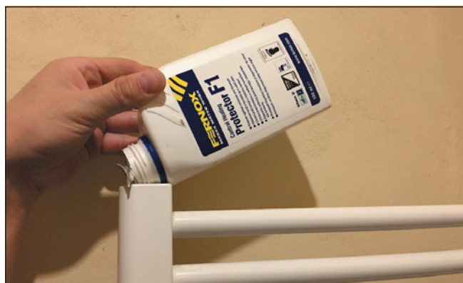
▲ Obr. 5 ● Aplikace inhibitoru Fernox Protector F1
