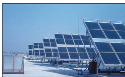
▲ Obr. 5 ● Velké konstrukce na ploché střeše panelárny (teplý beton rychleji tuhnul)
