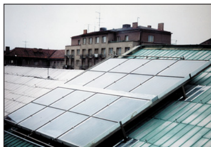
▲ Obr. 9 ● Menší konstrukce pro šikmé střechy
