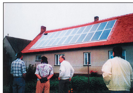
▲ Obr. 10 ● Integrace kolektorů do střechy RD
