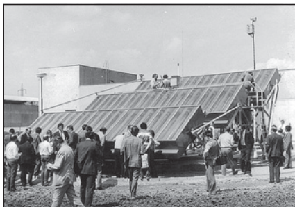
▲ Obr. 13 ● Otočný karusel z velkého množství oceli by dnes po sobě zanechal velkou uhlíkovou stopu
