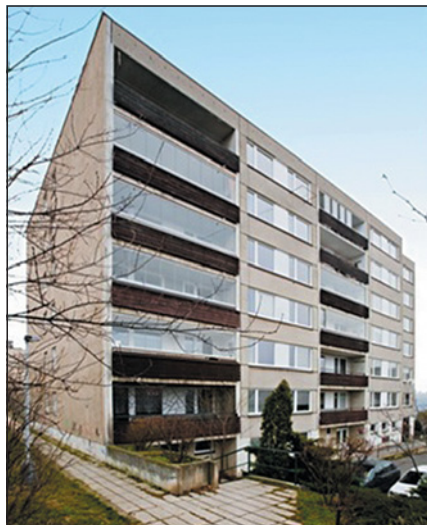
▼ Obr. 1 ● Původní stav objektu
