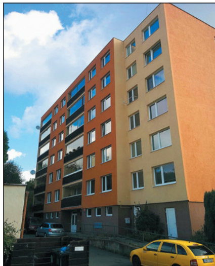
▼ Obr. 2 ● Bytový dům po rekonstrukci
