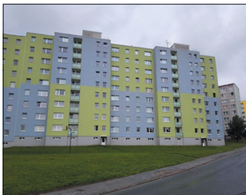
▼ Obr. 1 ● Posuzovaný bytový dům
