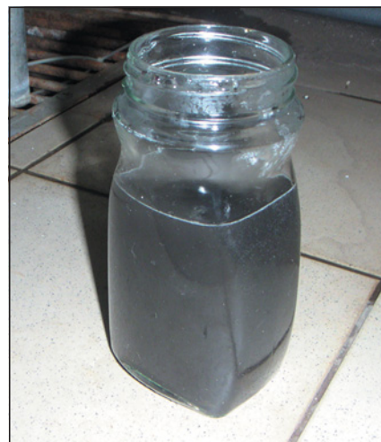
▲ Obr. 4 ● Oběhová voda byla plná korozních produktů, v reálné soustavě obsahující kyslík se voda stane agresivní vůči konstrukčním materiálům i těsnění
