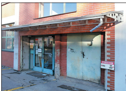
Obr. 29 Výtok ze střešních žlabů
