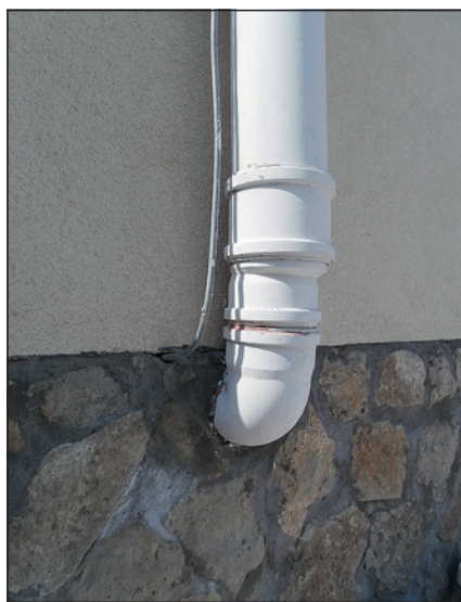
Obr. 18 Zmenšení průměru potrubí
