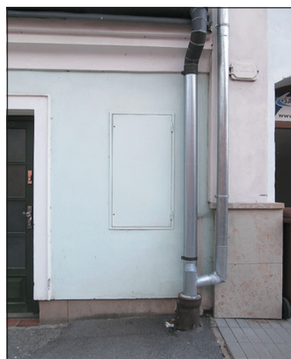
Obr. 14 Společný svod ze dvou střech
