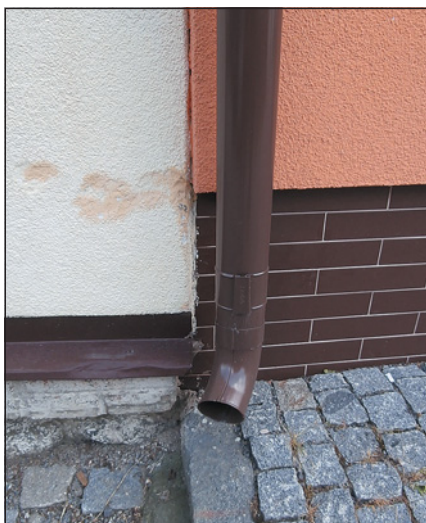
Obr. 28 Odvod volně na chodník
