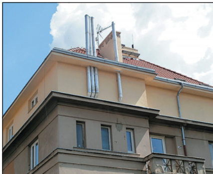
Obr. 16 Průchod potrubí atikou
