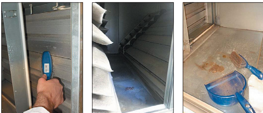
Obr. 5 Ukázka způsobů mechanického čištění
