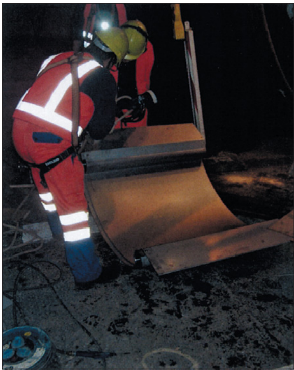
Tepelný výměník tvoří segmenty z nerezového plechu dlouhé 1 metr, které byly do sběrače spouštěny revizní šachtou
