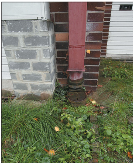
Obr. 22 Změna tvaru potrubí
