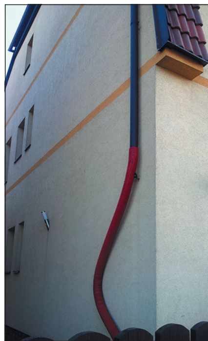
Obr. 20 Provizorní svislé potrubí
