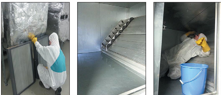
Obr. 6 Ukázka typických příkladů mokřeho čištění (vlevo eliminátor kapek, vpravo filtrační komora)
