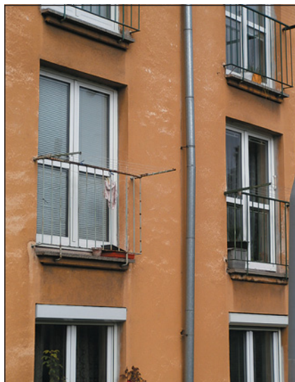
Obr. 19 Nedostatečné upevnění
