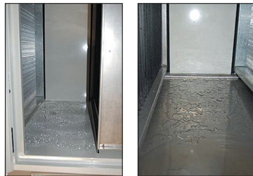
Obr. 12 Vany na kondenzát po čištění a před vysušením vody
