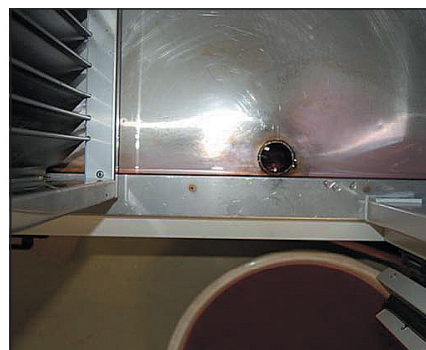
Obr. 8 Ukázka stojící kapaliny v místě odtoku (nezapuštěná vana nahoře, zapuštěná vana dole)
