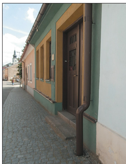
Obr. 25 Chybějící lapač
