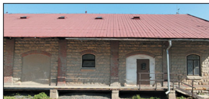
Obr. 11 Chybí část žlabu
