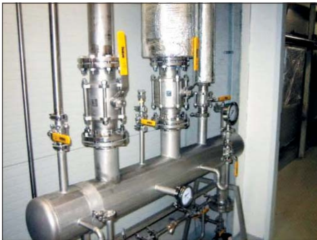
Obr. 2 Nerezový rozdělovač čisté páry
