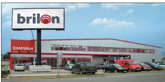
Slovenská pobočka BRILON sídlí v Bratislavě na Vajnorské ulici v objektu VO Empiria
