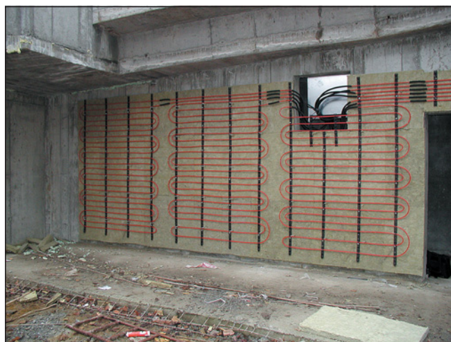
▼ Obr. 2 ● Stěnové vytápění REHAU
