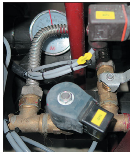
▲ Obr. 2 ● Doplnování otopné vody ze zpátečky priméru přes solenoidový ventil s obtokem; obtok slouží pro rychlejší počáteční napouštění soustavy
