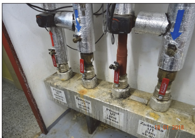
◀ Obr. 3 ● Oběhová kapalina byla agresivní vůči konstrukčním materiálům i těsnění
