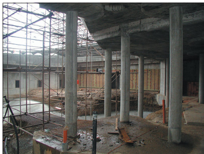
▼ Obr. 1 ● Pavilon ve výstavbě
