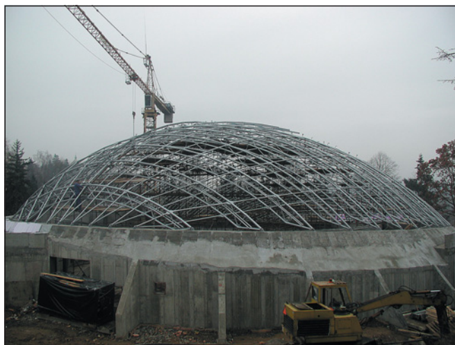
◀ Obr. 3 ● Střešní příhradová konstrukce
