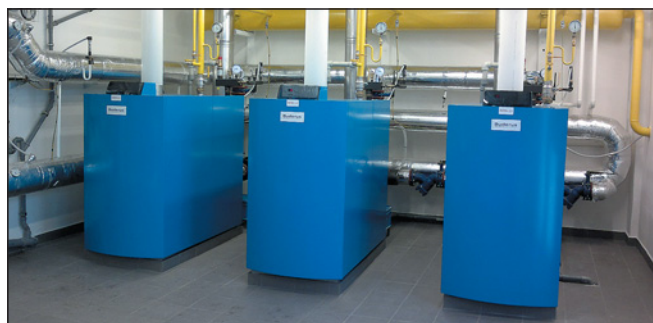
Obr. 3 Kaskáda úsporných stacionárních kondenzačních kotlů
