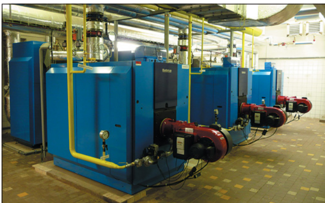
Obr. 1 Kaskádová kotelna s kotli Logano plus GE615
