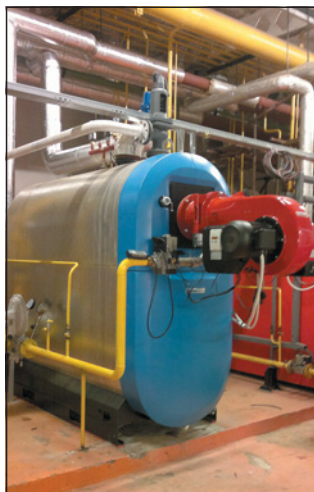
Obr. 1 Kaskádová kotelna s kotli Logano plus GE615
