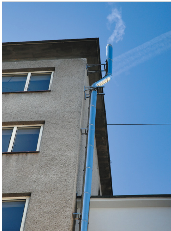
▼ Obr. 4 ● Komínový systém DW25 vedený po fasádě
