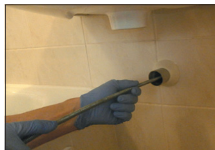
▼ Obr. 4 ● Čištění kanalizačního potrubí ruční čisticí pružinou
