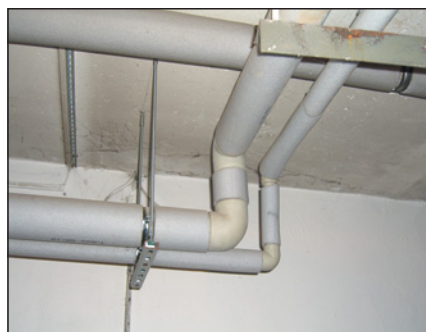
▲ Obr. 2 ● PPR potrubí po výměně
