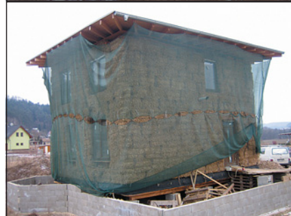
Obr. 1 Posuzovaný objekt před dokončením – SZ a SV pohled
