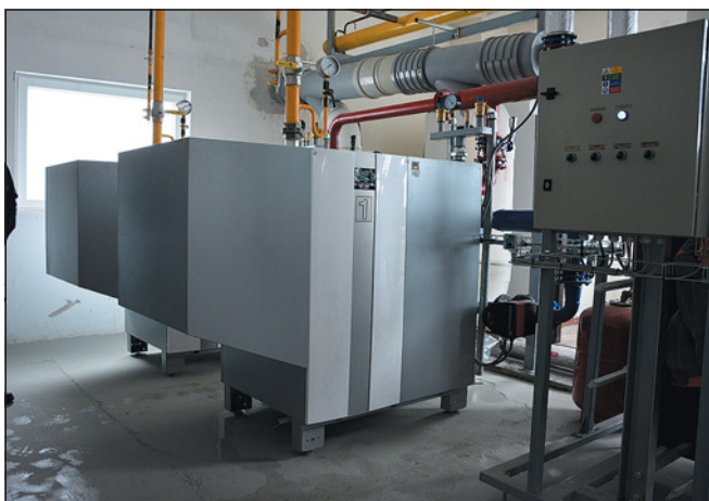
▲ Obr. 1 ● Kaskáda dvou kotlů MGK-2 630 v zapojení s ochranou kotlů
