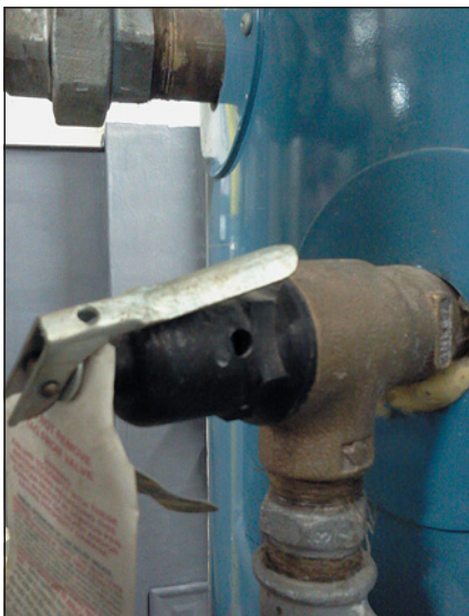
▲ Obr. 3 ● Kombinovaná teplotní a tlaková pojistná armatura osazená na plynovém zásobníkovém ohřívači vody
