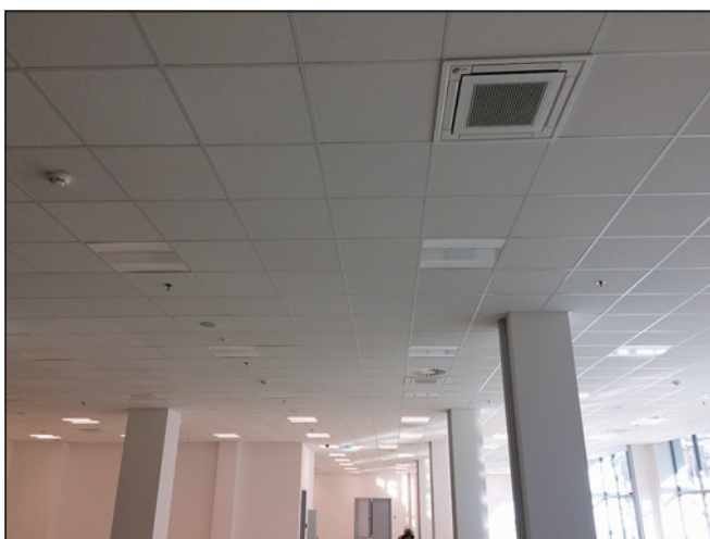
▲ Obr. 5 ● Instalace vnitřních jednotek FXZQ
