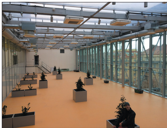
▲ Obr. 6 ● Jednotky FXUQ-A v respiriu
