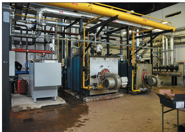
▲ Obr. 2 ● Nové řešení vs. staré; trend zmenšování kotlů, starý kotel ČKD s výkonem 800 resp. 1200 kW je téměř dvojnásobně větší než kompletní řešení s kotlem MGK-2 a oddělovacím výměníkem
