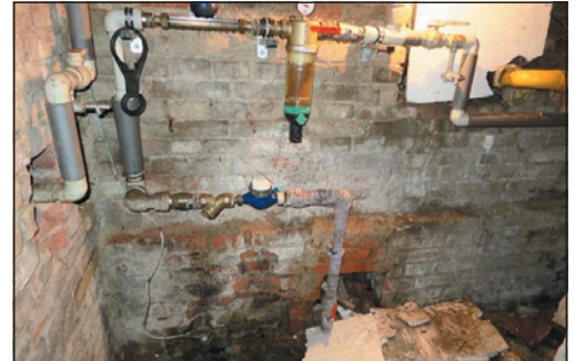
▲ Obr. 2 ● Vstupní uzel kolem vodoměrné sestavy
